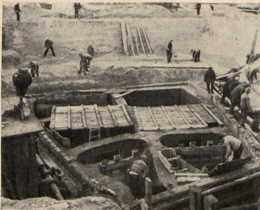
Rys. 14. Fundamenty budynku pomp i sit.
