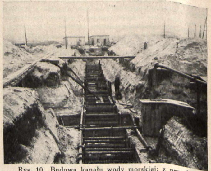
Rys. 10. Budowa kanału wody morskiej; z przodu studnia rozgałęźna wody zimnej i ciepłej.
