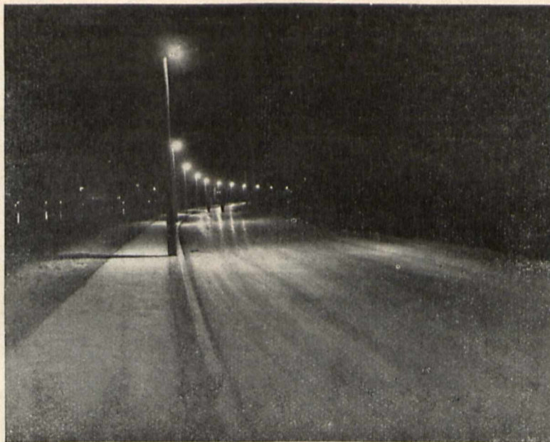
Rys. 2. Odcinek szosy asfaltowej Warszawa—Otwock, oświetlony armaturami z żarówkami normalnymi, wolframowymi.
