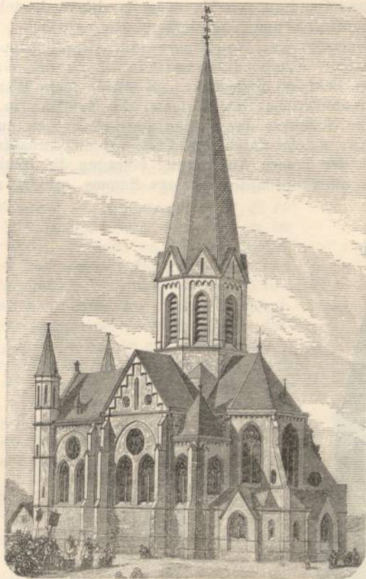
Fig. 1688. Katholische Kirche in Welling (Architekten A. Rincklake & Pickel).
