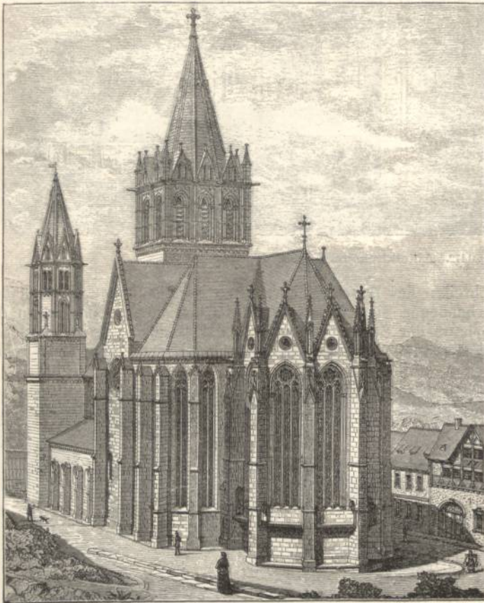
Fig. 1474. Liebfrauenkirche zu Arnstadt. Südostseite (Architekt Hubert Stier).
