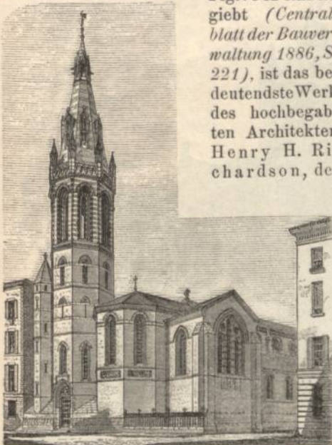
Fig. 1840. Englische Kirche zu Rom (Architekt Street).
