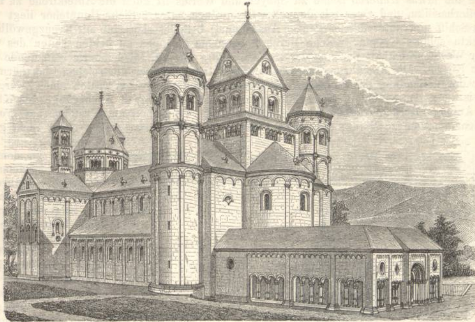
Fig. 1472. Abteikirche zu Laach. Nordwestansicht.
