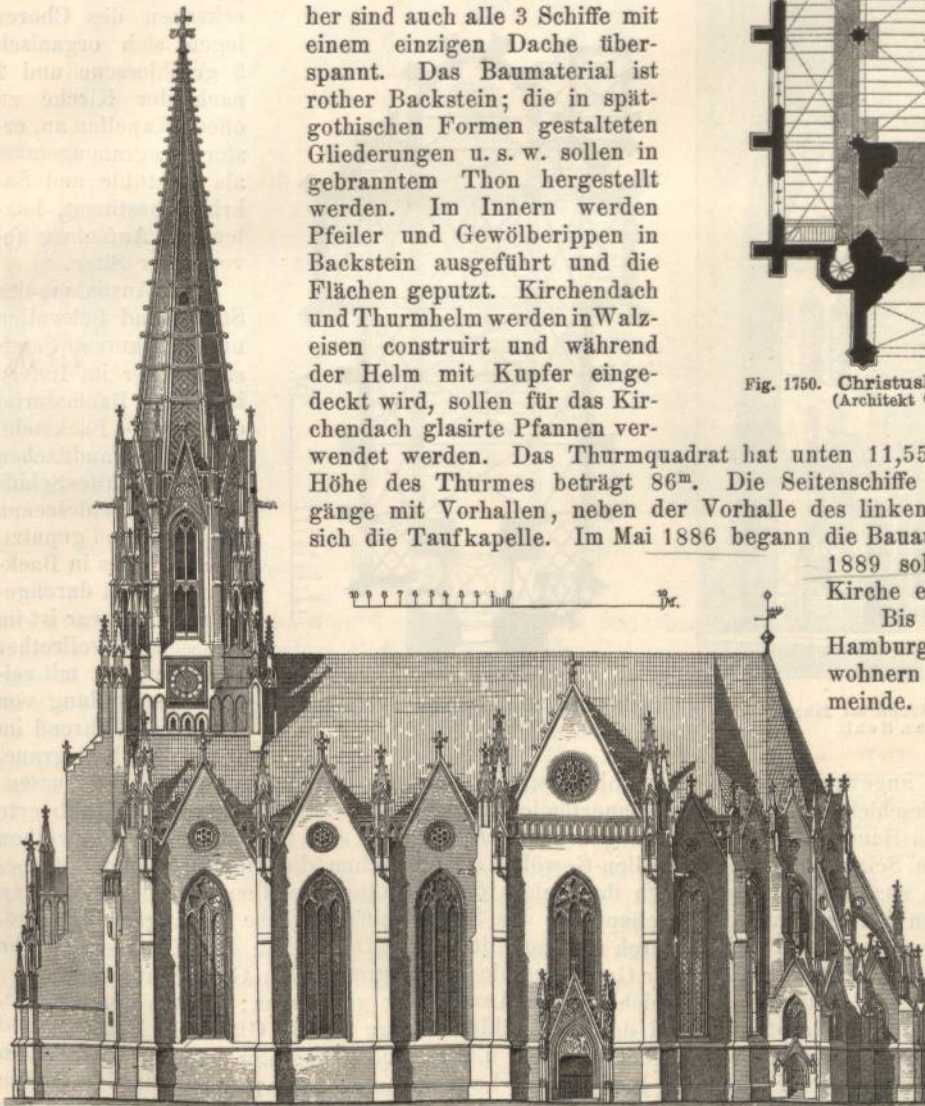
Fig. 1751. Christuskirche in Hannover (Architekt C. W. Hase).
