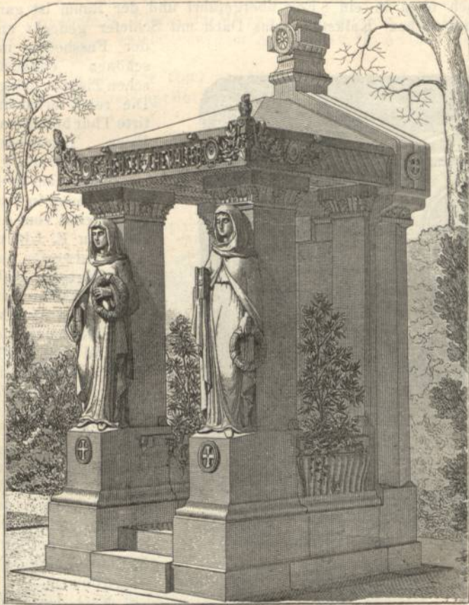
Fig. 2092 Grabmal in Passy (Architekt E. Lheureux).
