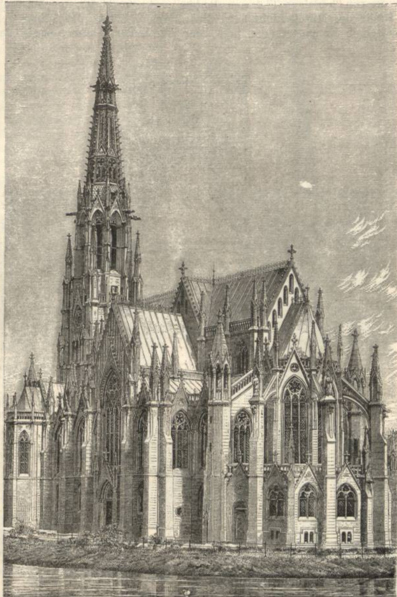
Fig. 1727. St. Johanneskirche in Stuttgart (Architekt Dr. v. Leins).
