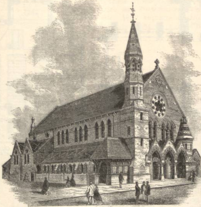
Fig. 1700. St. Andrew's in London (Architekt Charles F. Hayward).
