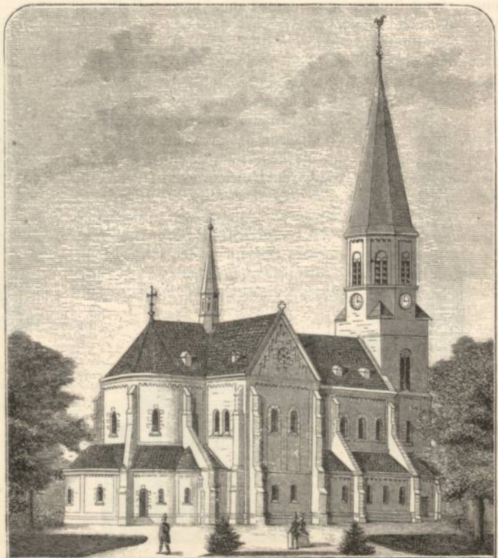
Fig. 1819. Pfarrkirche zu Harsum bei Hildesheim (Architekt Chr. Hehl).
