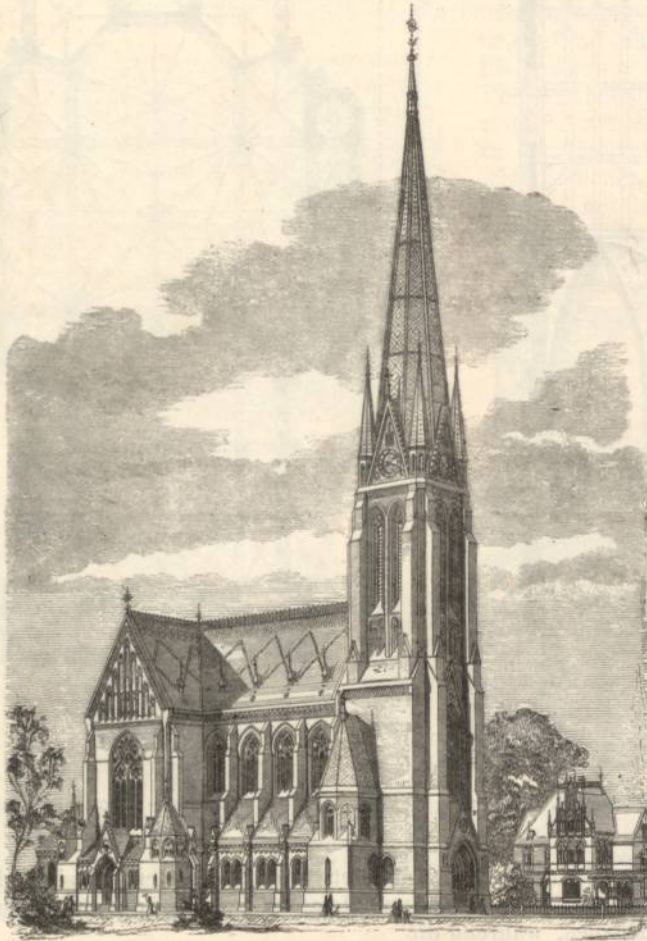
Fig. 1757. St. Johannes-Kirche in Altona (Architekt Joh. Otzen).
