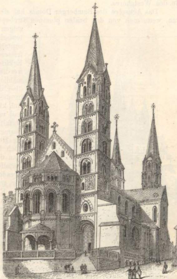
Fig. 1456. Ostseite vom Dom zu Bamberg. Erbaut von ca. 1100–1274.
