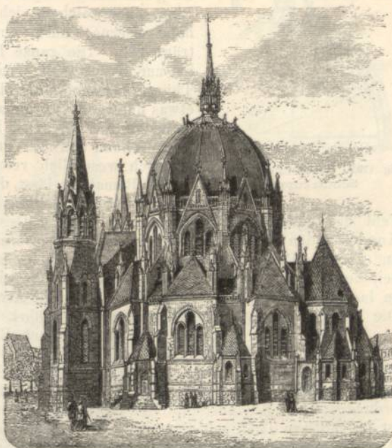
Fig. 1792. Pfarrkirche in Fünfhaus-Wien (Architekt Fr. Baron Dr. Schmidt).
