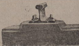
Rys. 13a. Wkładka, wzmacniająca podkład. Rys. 13b.
