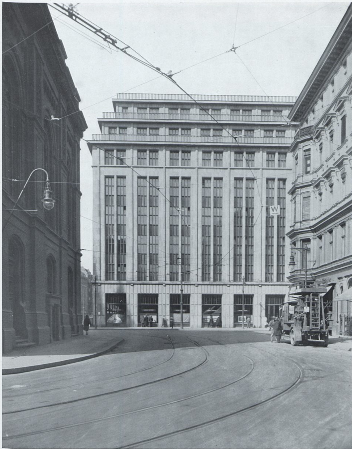
SCHERLHAUS, BAUTEIL JERUSALEMER ECKE KOCHSTRASSE. 1927/28
