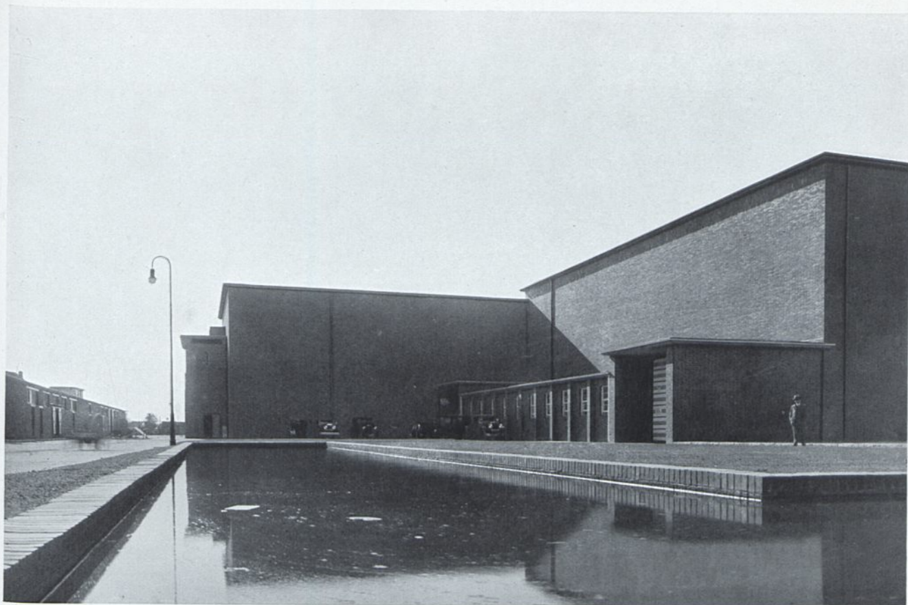
TONFILM-ATELIERS, NORD- UND OSHALLE MIT GARDEROBENANBAUTEN
