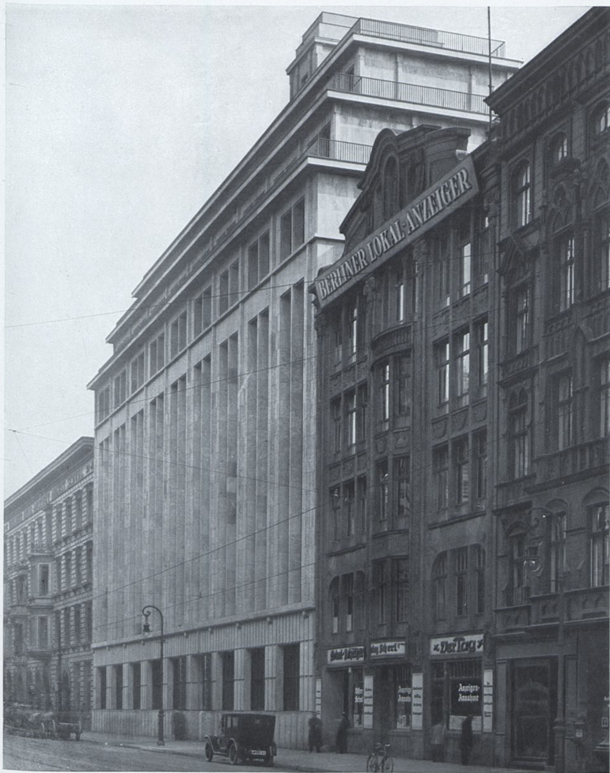
SCHERLHAUS, BAUTEIL ZIMMERSTRASSE. 1925/26
