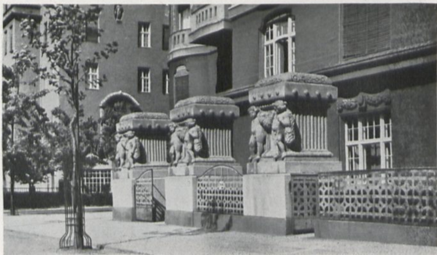
15. Überladener Eingang zu einem Miethaus in der Kaiserallee, Berlin W
