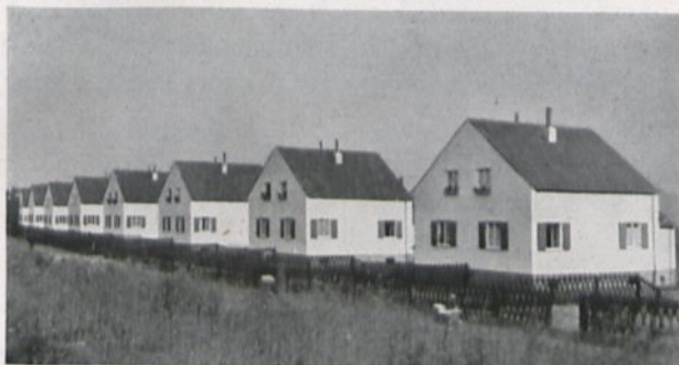
47 und 48. Neue städtische Siedlungsbauten auf dem Exerzierplatz bei Saarbrücken; Fa-Fa-Bauweise nach Prof. Paul Schmitthenner-Stuttgart (Hier verbinden sich Schnelligkeit der Herstellung und Billigkeit mit menschenwürdigem Äußeren zum — für unsere Verhältnisse — vorbildlichen Kleinhaus)
