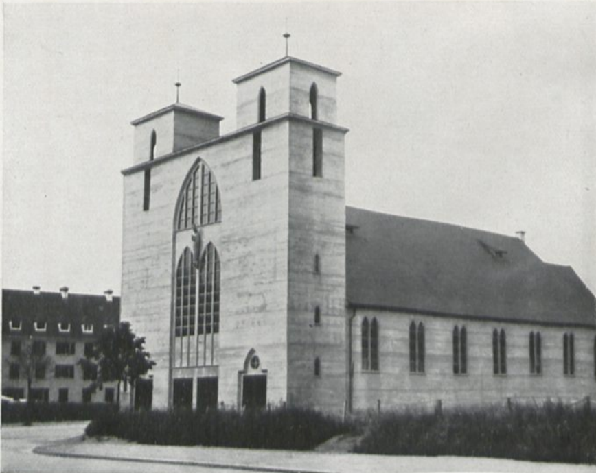
39. Neue katholische Kirche in Freiburg im Breisgau. Architekt: Erzbischöfliches Bauamt. (Rohr Eisenbetonbau mit sichtbaren, wenn auch beabsichtigten, Spuren der einstigen Verschalung)
