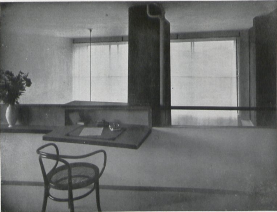
3. Der Schreibtisch aus Eisenbeton. Maschinell hergestellt, entbehrt er des Persönlichen
