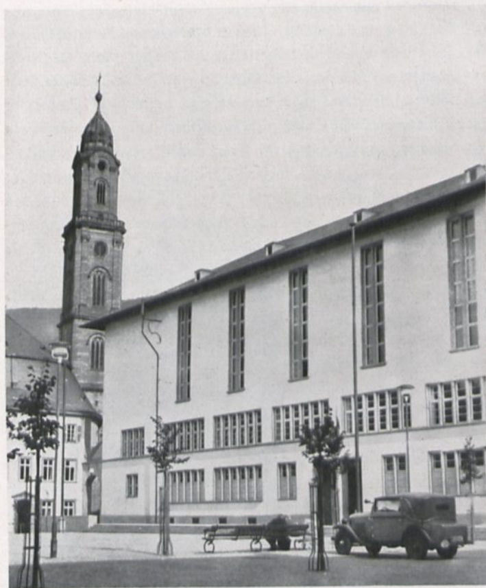
52. Universitäts-Neubau in Heidelberg. Architekt: Prof. K. Gruber-Danzig (Die in den Bauwerken verkörperten Ideen zweier Epochen prallen hier be- sonders heftig aufeinander)
