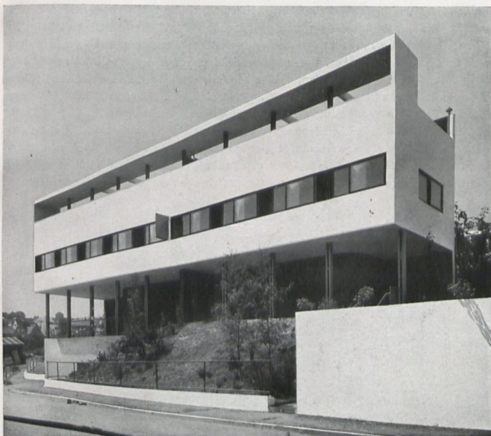
10. Weißenhofsiedlung Stuttgart. (Das Haus, das auf Stelzen steht)
