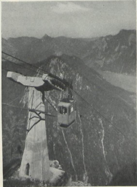
Abb. 179. Eisenbetonstütze der Ebensee-Bahn (Bleichert).
