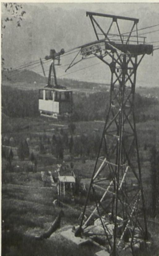
Abb. 180. Eiserne Stütze der Patscherkofelbahn (Bleichert).
