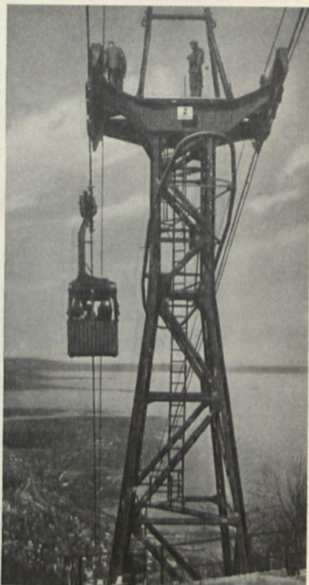
Abb. 181. Führungsbügel der Pfänderbahn (Bleichert).
