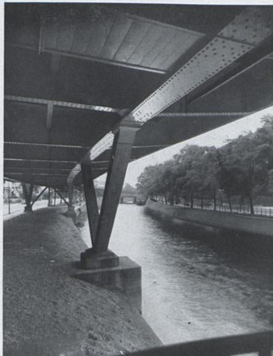
Bild 21. Unteransicht des neuen Bahnhofs mit Spreize (festes Lager).
