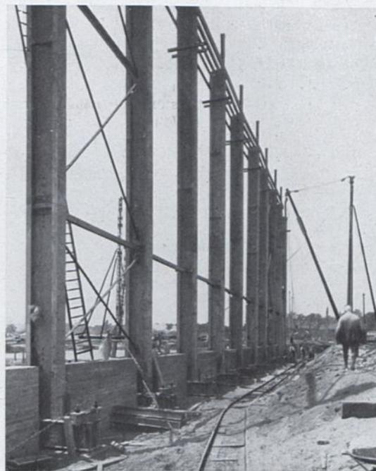
Bild 8. Aufstellung der Seitenhallenstützen mit dem Schwenkmast.
