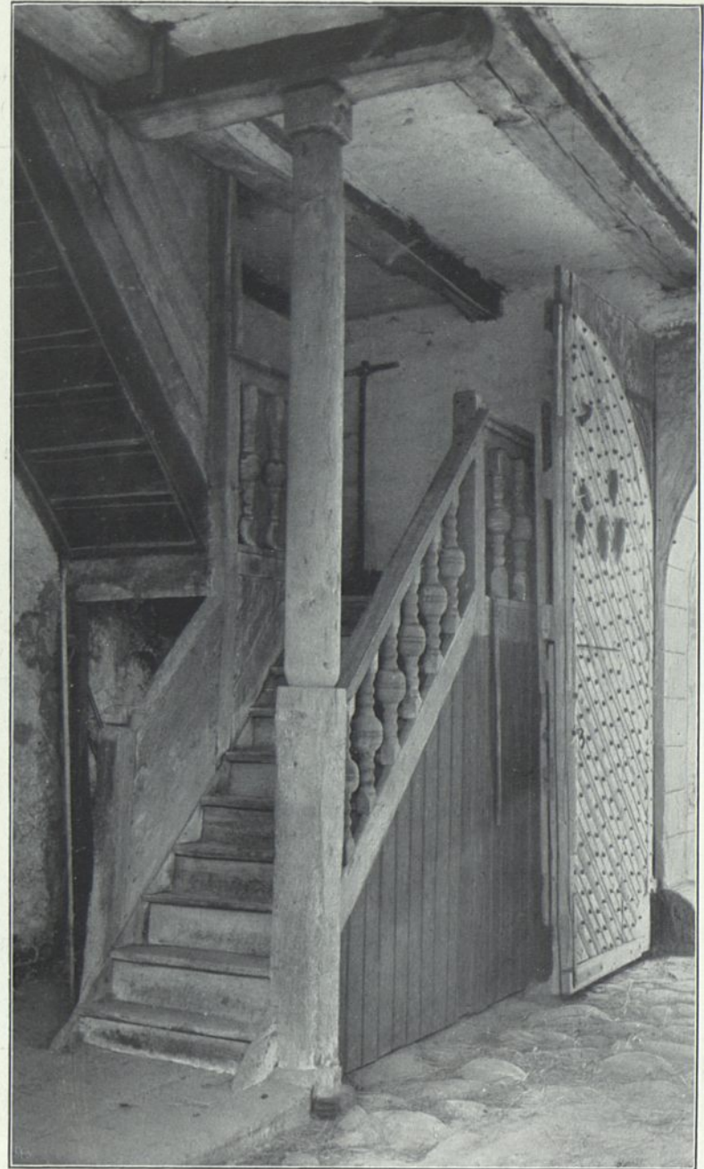
60. Schloß Holtfeld. Treppe im äußeren Torhaus.
