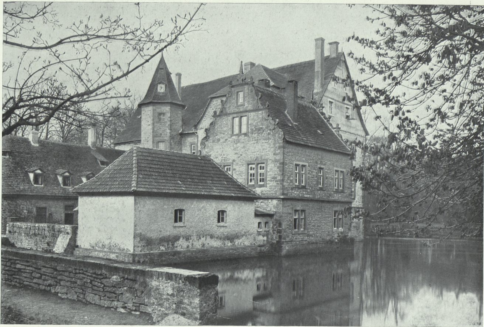
103. Gut Schreckhausen. Ansicht von der Zufahrt aus.
