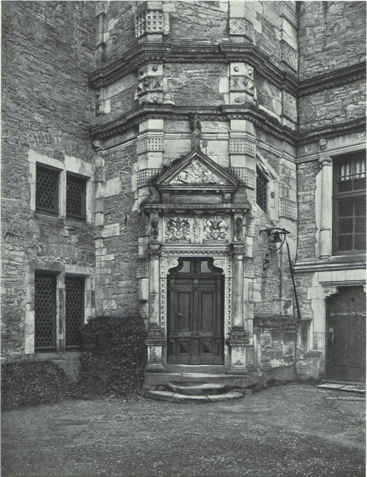
201. Hämelschenburg. Treppenturm am Nordwestflügel.
