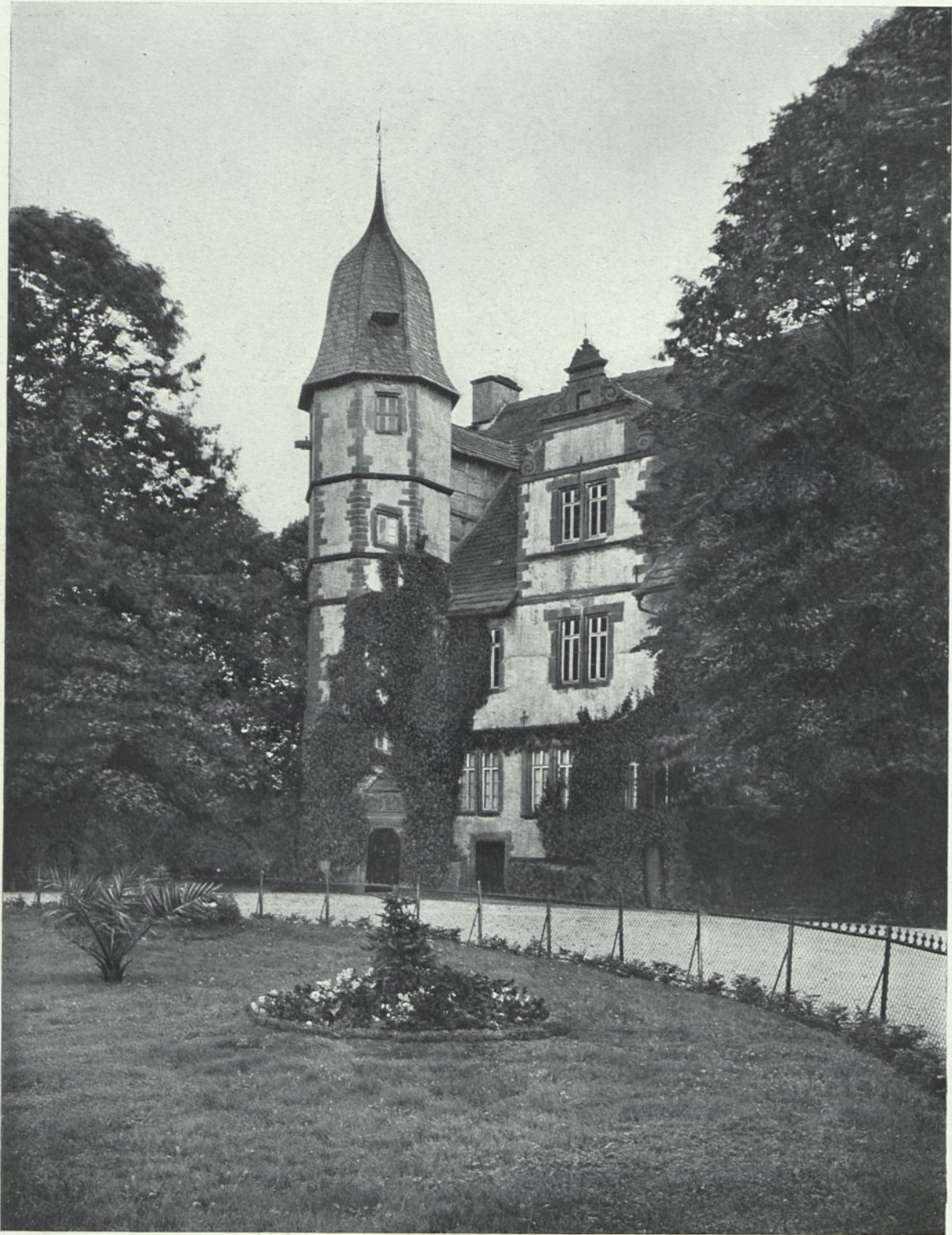
193. Schloß Wendlinghausen. Turm an der Hauptfront.
