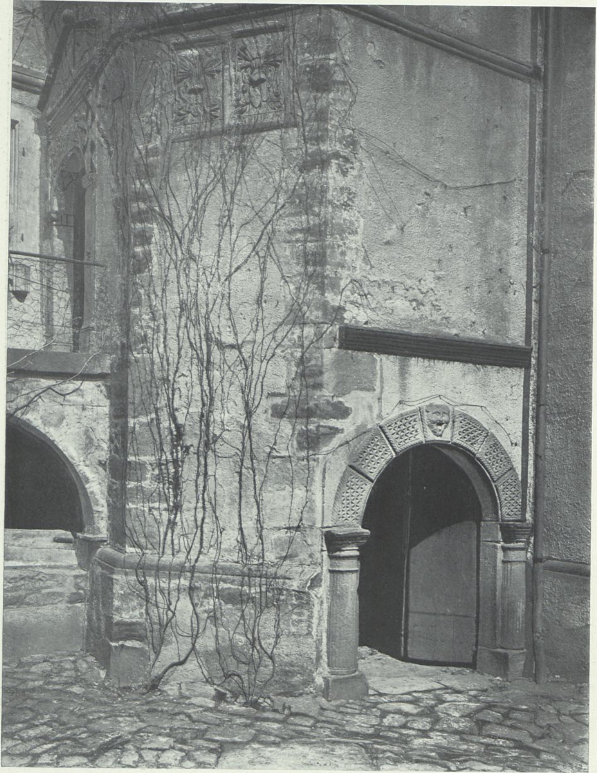
47. Grevenburg. Treppenturm im Hof.
