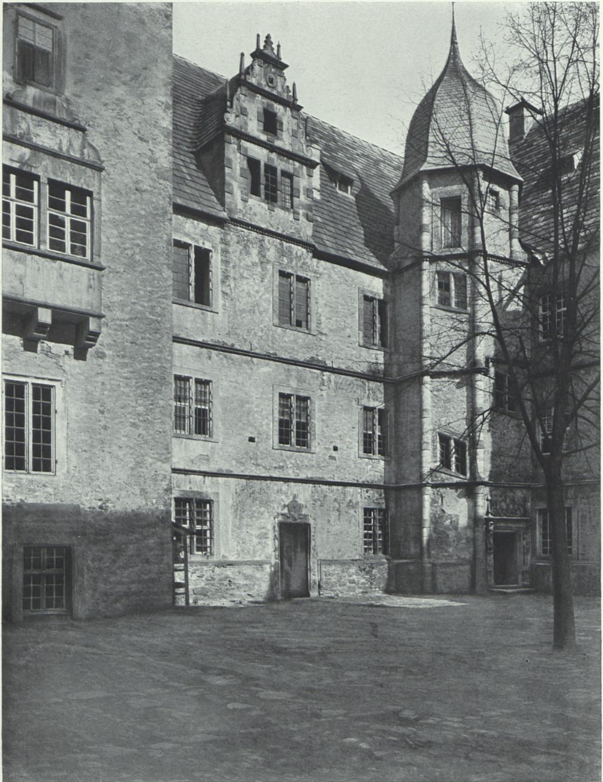
212. Schloß Varenholz. Treppenturm an der Nordostseite des Hofes.
