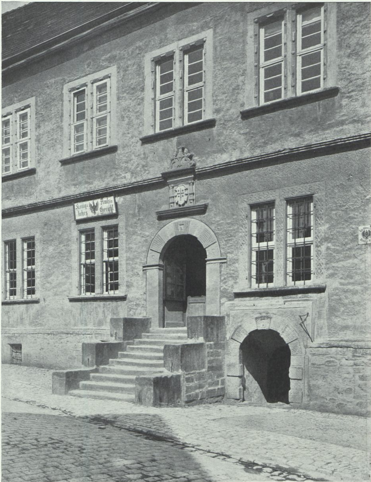
36. Rathaus in Nieheim. Eingang.
