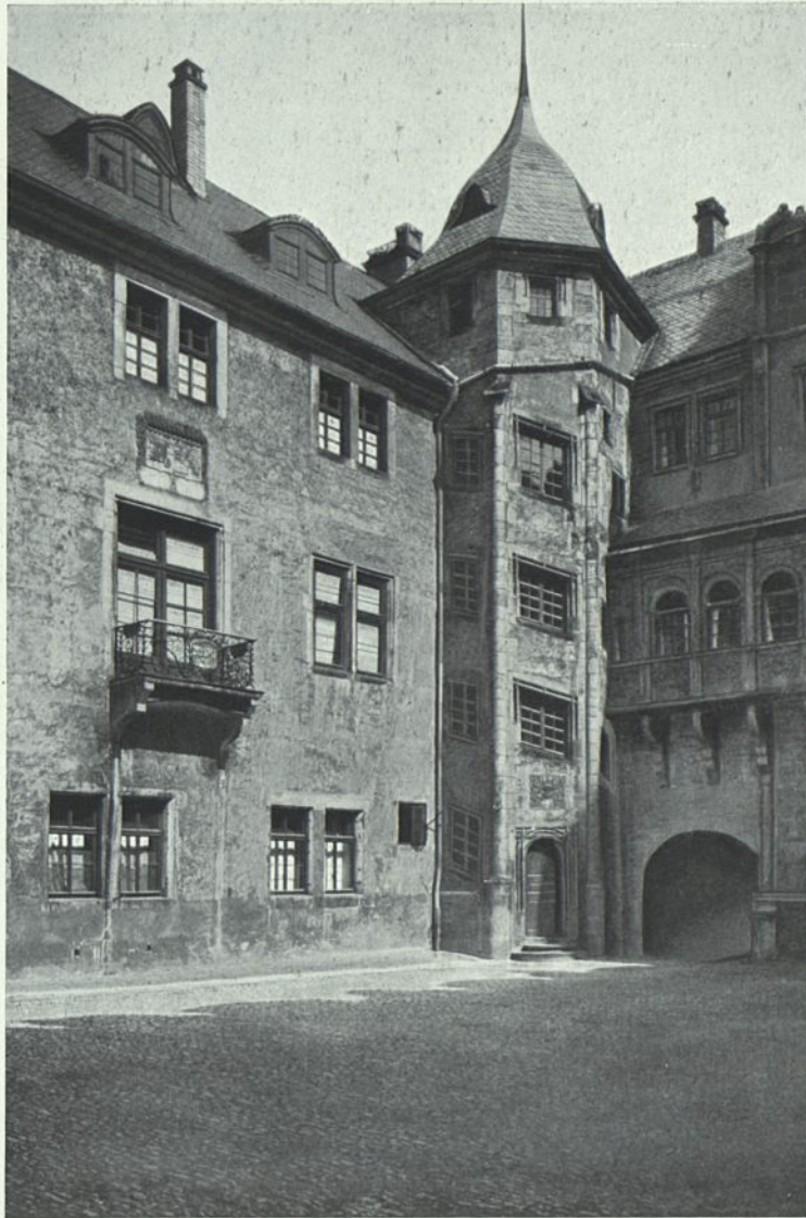
175. Schloß Detmold. Treppenturm im Hof.
