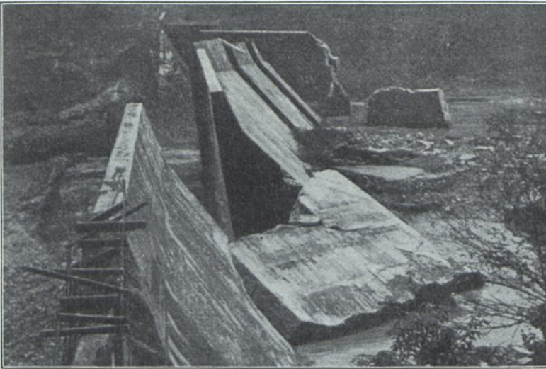
Abb. 98d. Austinsperre. Ansicht vom rechten Ufer.
