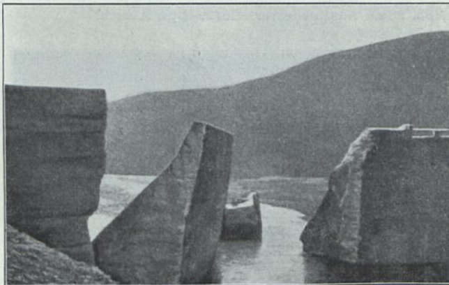
Abb. 98e. Austinsperre. Blick talabwärts durch die östliche Durchbruchstelle.
