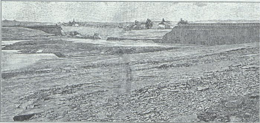
Abb. 94b. Bouzey. Wasserseitige Ansicht nach dem Bruch am 27. April 1895.
