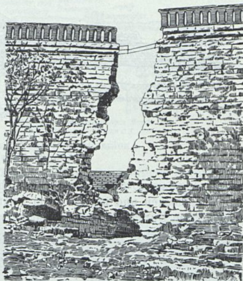
Abb. 96e. Nashville-Behälter. Bruchstelle a in Abb. 96d.
