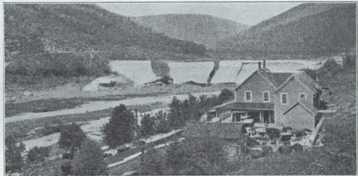
Abb. 98a. Austinsperre. Luftseitige Ansicht
