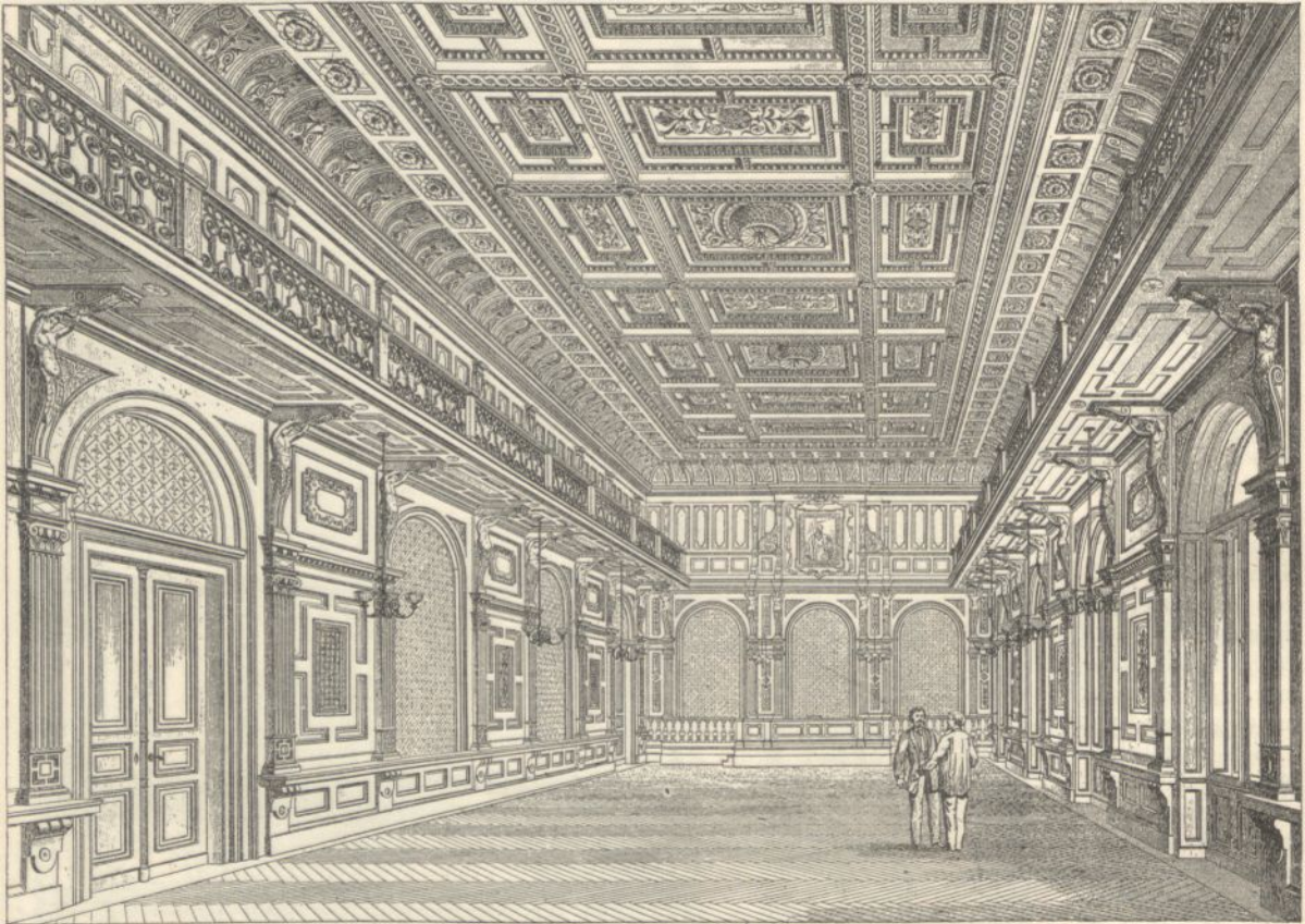
Fig. 723. Versammlungssaal im Hause des Oesterr. Ingenieur- und Architekten-Vereins in Wien (Architekt Otto Thienemann).
