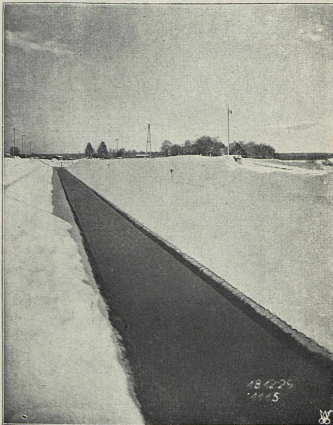
Rys. 11. Kanał roboczy o przełyku 75 \text{ m}^3/\text{sek.}
