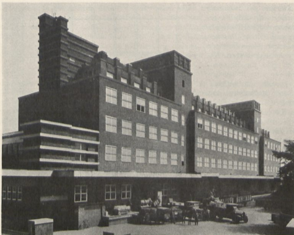
Abb. 416. Hauptlagerhaus der G. H. H. Oberhausen. Ansicht des fertigen Baues. Architekt Peter Behrens. Ausführung: Gutehoffnungshütte Oberhausen.
