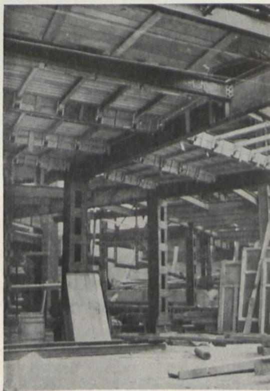
Abb. 334. Hochhaus der Berg- und Hüttenwerks-Ges. in Prag. Aufhängung der Decken- und Trägerschalung. Entwurf des Verfassers. Ausführung: Brückenbauanstalt Karlshütte bei Friedek.
