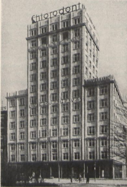
Abb. 425. Europahaus Leipzig. Arch. O. P. Burghardt. (Nach Rohrer: Der Stahlbau 1930, S. 186.)
