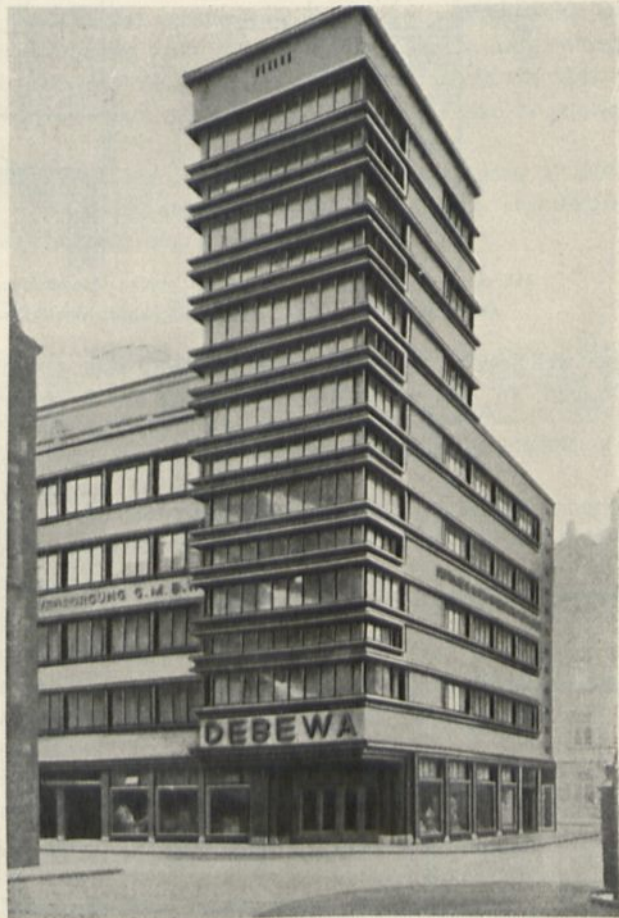
Abb. 73. Turmhaus Debewa, Mannheim. Architekt: Fritz Nathan, Frankfurt a. M.
