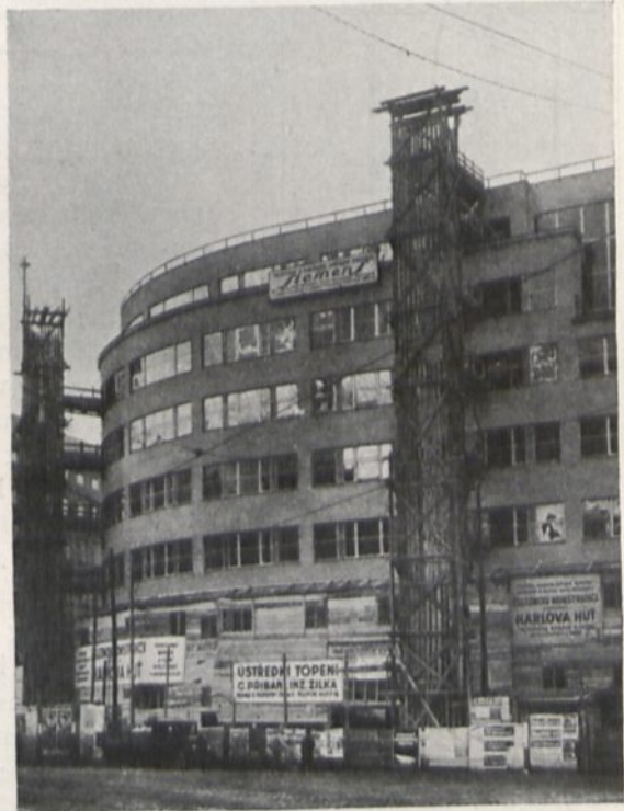
Abb. 312. Hochhaus der Berg- und Hüttenwerkgesellschaft in Prag. Anordnung der Aufzugtürme.
