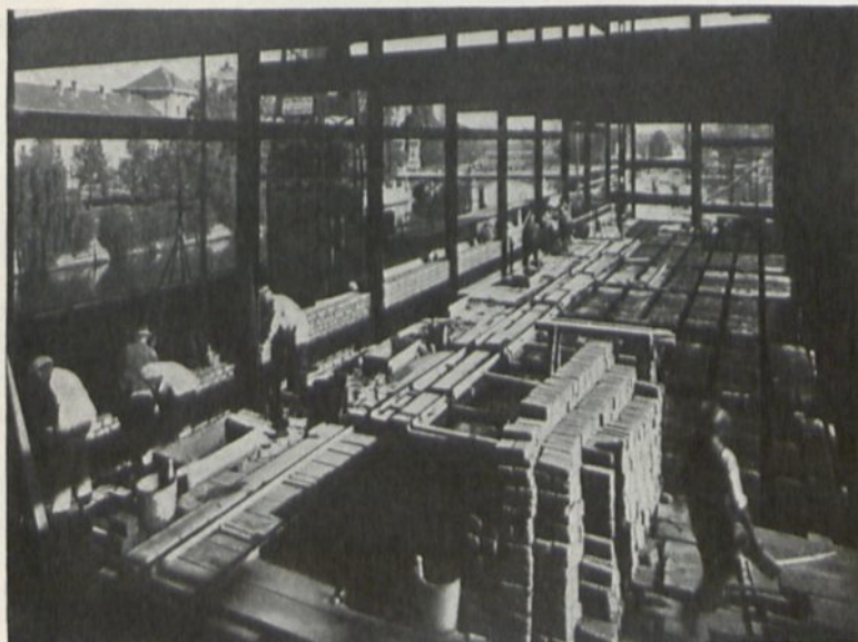
Abb. 336. Deutsches Museum in München. Herstellung der Decken und Wände. Ausführung des Stahlskelettes: Vereinigte Stahlwerke A. G. Dortmunder Union.
