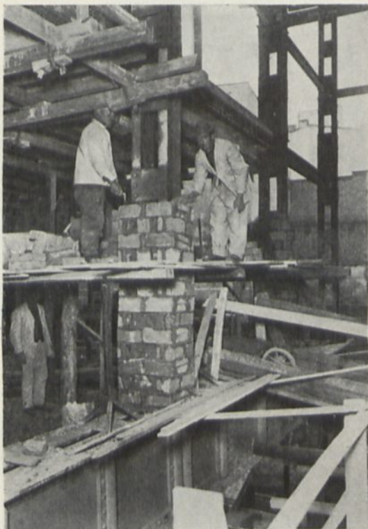
Abb. 340. Hochhaus Suschitzky, Prag. Ausmauerung einer Stütze. Ausführung: Eisenwerk Witkowitz.
