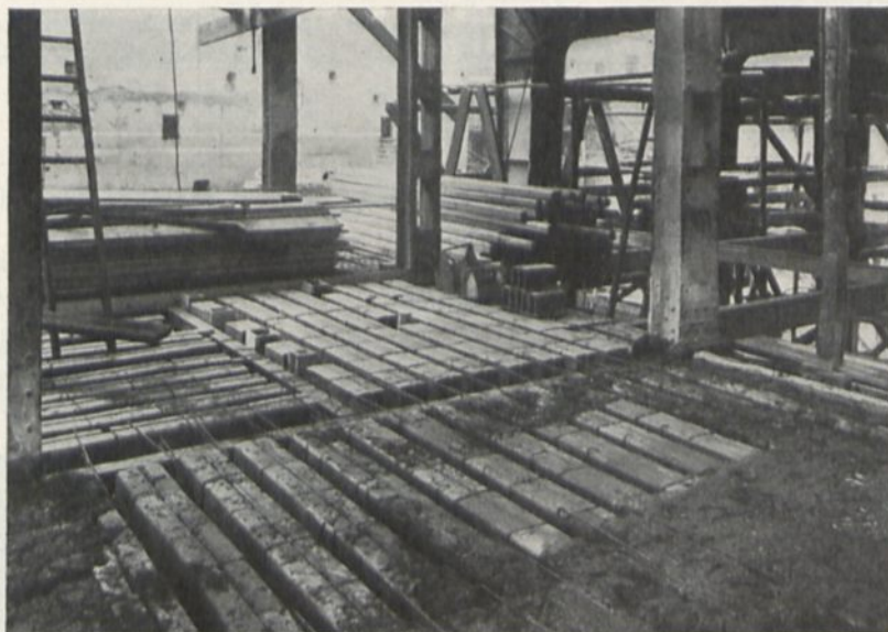
Abb. 335. Hochhaus Suschitzky Prag, Herstellung der Hohlsteindecken.
