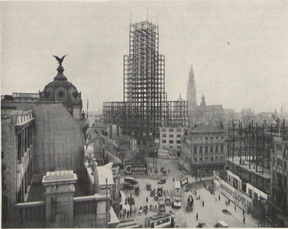
Abb. 452. Hochhaus der Allgem. Bankvereinigung in Antwerpen. Ansicht des fertigen Stahlskelettes. Ausführung: DEMAG Aktienges. Duisburg.
