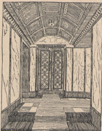
Abb. 211. Windfang in reicher Ausstattung
