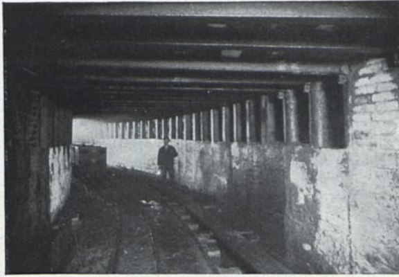
Strecken-Dauerausbau in sehr druckhaftem Gebirge. Stahlkappen, Betonpfähle, Rohrstempel mit Betonfüllung und Betonstoßmauer
