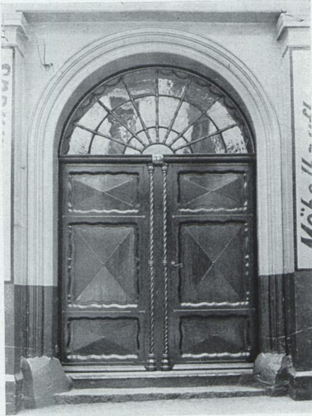
Abb. 11 Rundbogiges Portal, Krakauer Straße 33
