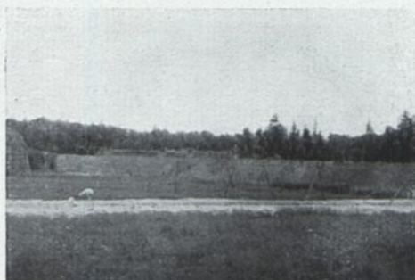
Erdarbeiten zur Herstellung der Gleisanlage Beuthengrube
