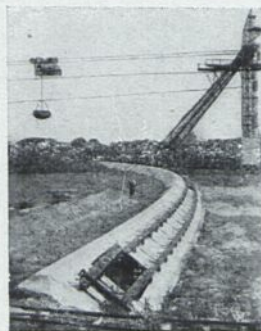
Radialfundament auf Hohenzollerngrube der Gräfl. Schaaffgotsch'schen Werke G. m. b. H.
