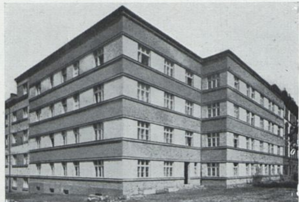
NEUBAU IN HINDENBURG O.-S., SCHECHEPLATZ-FLORIANSTR.
