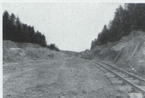
Erd- und Rodungsarbeiten Beuthengrube
