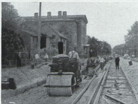
Planieren, Walzen und Legen von Gleisen
