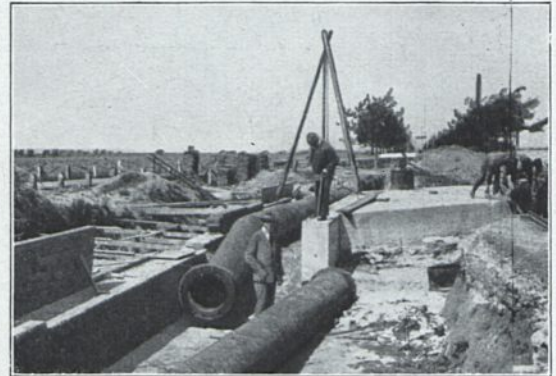
Verlegung einer 400 und 600 mm i. L. starken schmiedeeisernen Druckrohrleitung durch Schweißung
