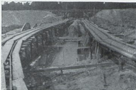
Ausschachtungen zur Herstellung der Gleisanlage für die neue Beuthengrube
