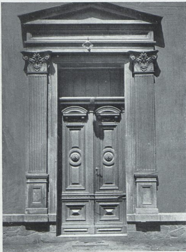
Abb. 14 Portal, Ecke Goy- und Hubertusstraße
