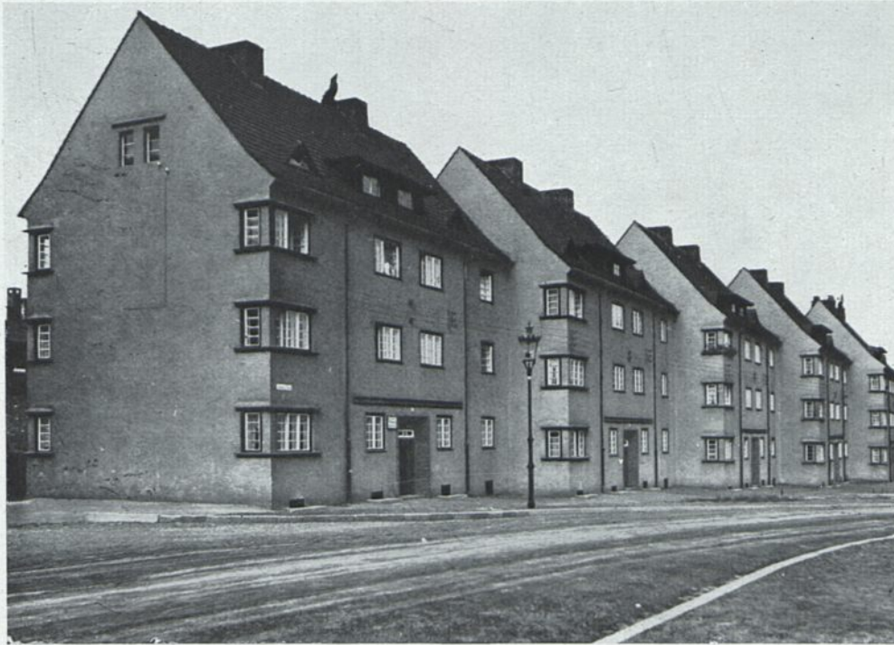
Wohnhausgruppe der Flüchtlings-Siedlungs-Baugenossenschaft m. b. H. in Beuthen O/S., Rococostraße
