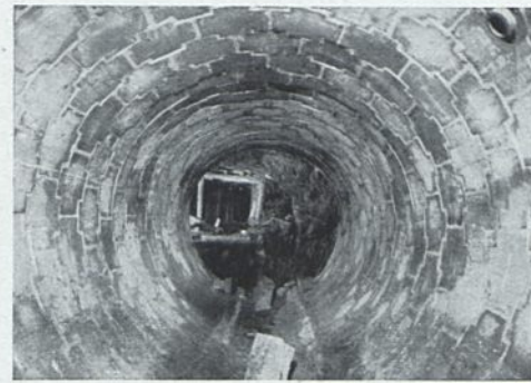
Stollenausbau auf Ferdinandgrube der Kattowitzer A. G.
