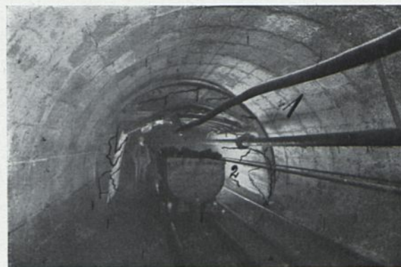
Zu 1: Dauerausbau in sehr druckhaftem Gebirge mit drahtarmierten Formsteinen und seilarmierter Streckenmauer. Steht nach 2jähriger Dauer fest und unverritzt in sehr druckhaftem Gebirge.
