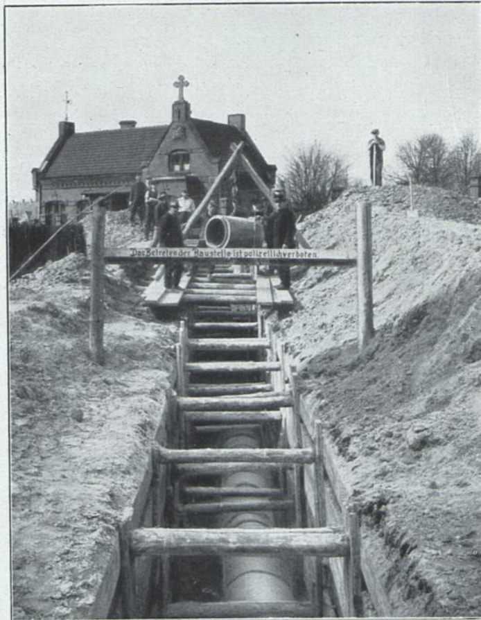
Tonrohrleitung 250 mm und Zementrohrkanal 600 mm l. W. bis zu einer Tiefe von 6,0 m für die Stadt Beuthen O.-S.
