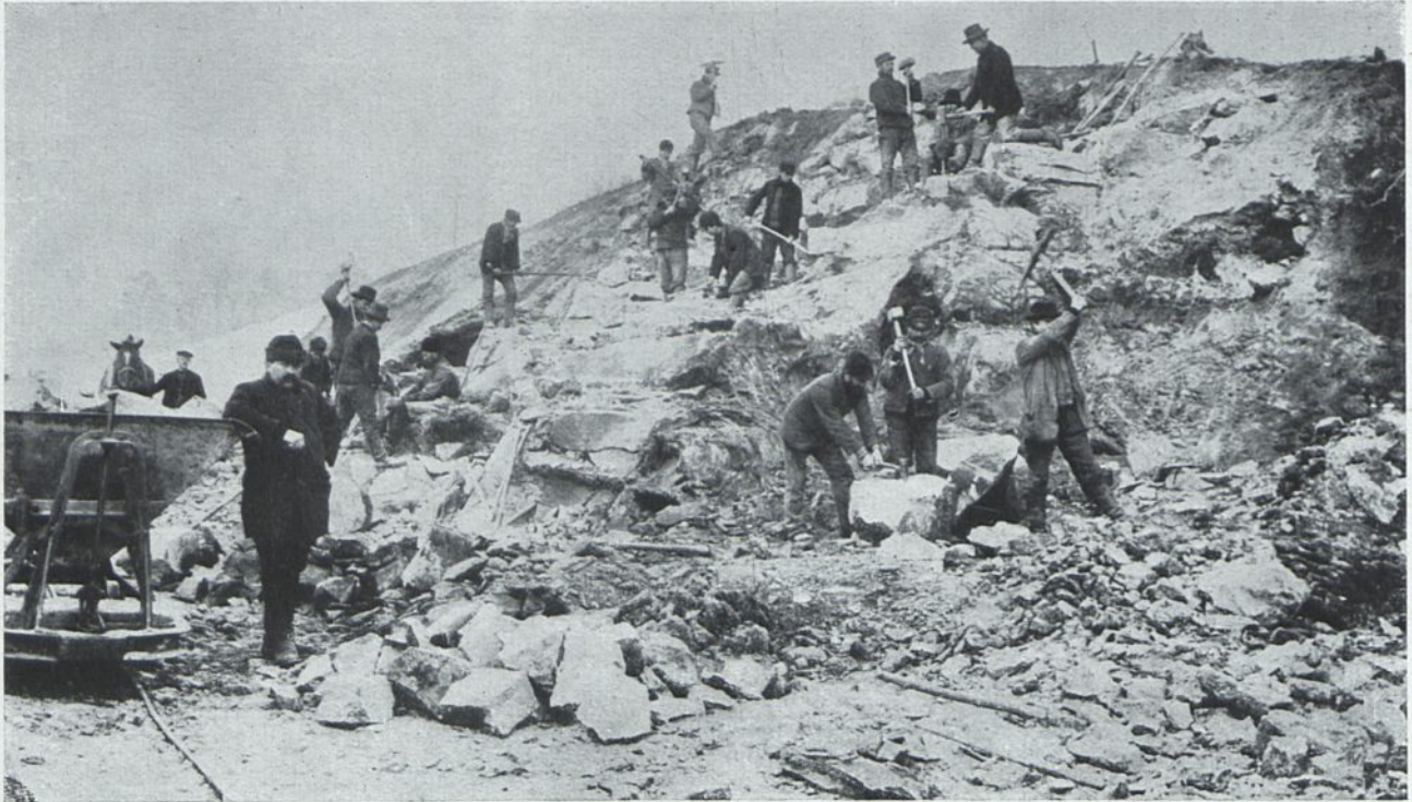
Chausseebau Steinkirche—Pogarth, Kreis Strehlen. Durchgesprengter Felskegel bei Stat. 4,8.
