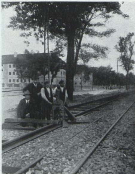
BREITFUSS-SCHIENEN Oberbau OHNE SCHWELLEN
