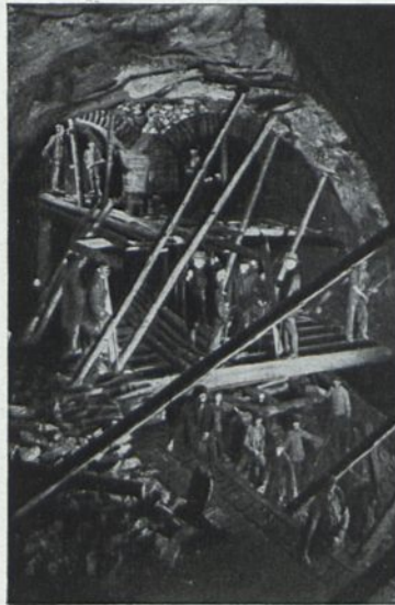
Ausbruch und Ausmauerung eines Schachtfüllortes
