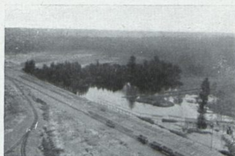
Legen von Schwellen und Gleisen für die neue Beuthengrube
