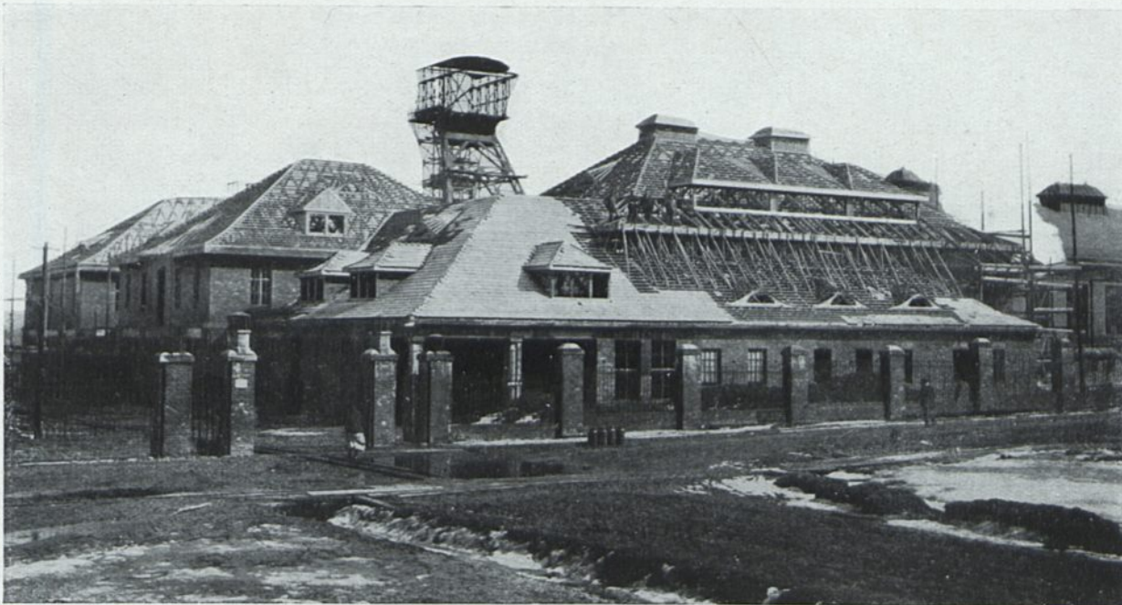
Schachtanlage in Groß-Turze
