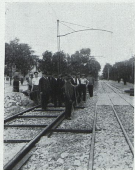
BREITFUSS-SCHIENEN Oberbau OHNE SCHWELLEN
