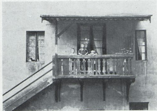
Abb. 17 Offene Galerie mit Aufgang, Lange Straße 47
