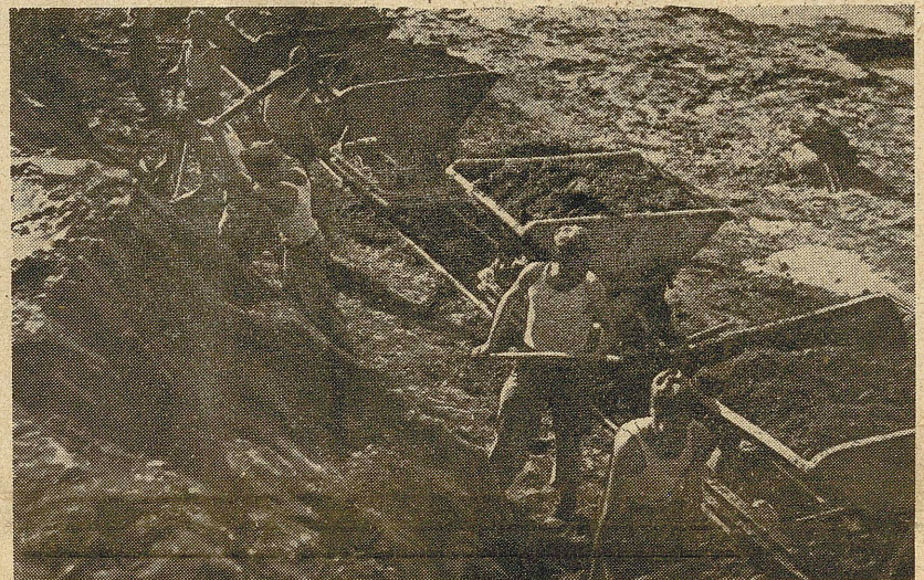
Junacy 18 Brygady SP przy budowie autostrady Gdynia—Gdańsk.
