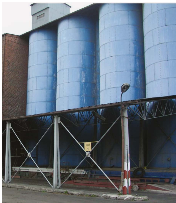
Fot. 1. Widok zewnętrzny elewatora PZZ „Opole – Port”
