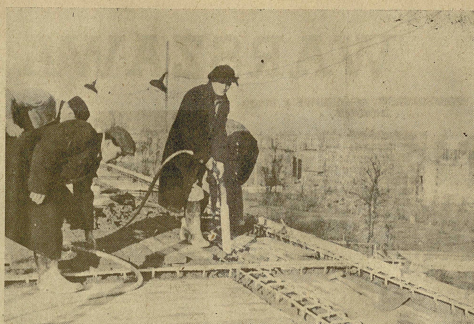
Rozbudowa gmachów sejmowych w Warszawie
