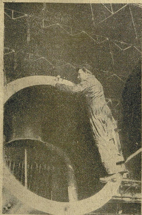
Montowanie rur wlotowych w parowozach
