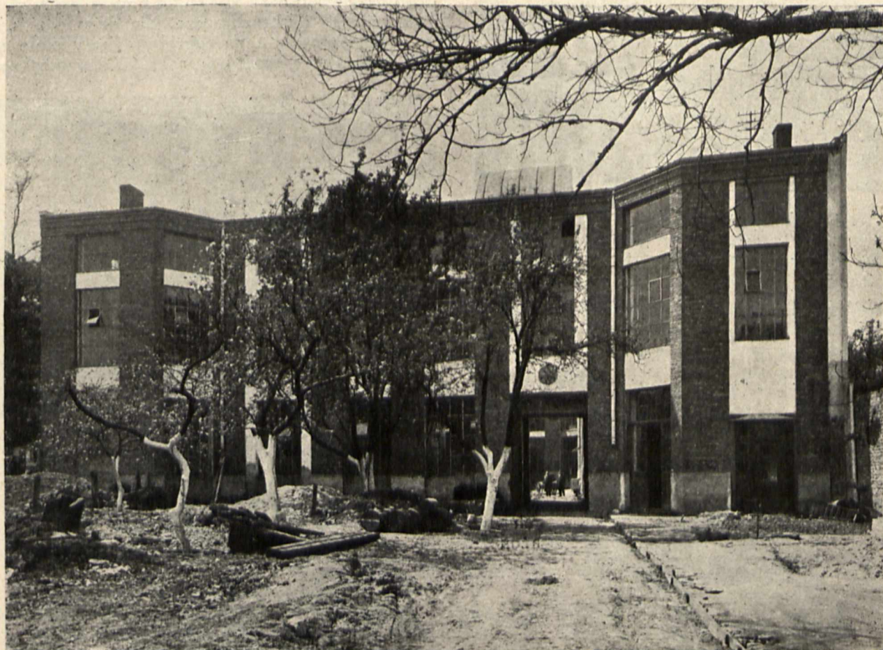
Nowowbudowana fabryka przy ulicy Okopowej Nr. 19 (na ukończeniu).
