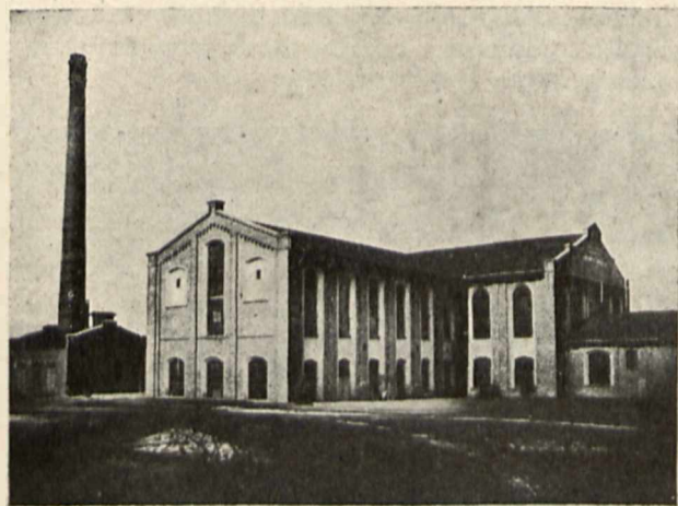
Zychlin. Główny budynek fabryczny.
