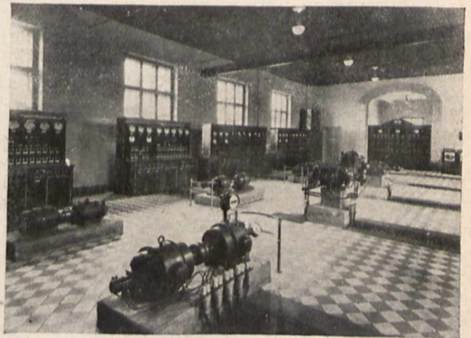
Hala maszyn (widok ogólny) Akademii Górniczej w Krakowie.
