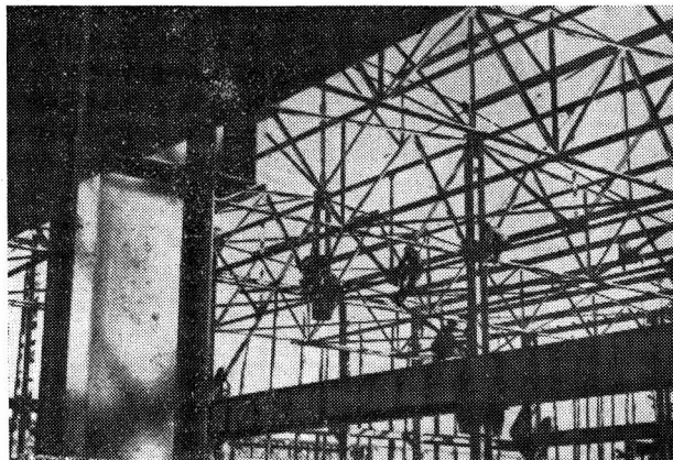
(foto NH Gładyszek Mieczysław) Montaż konstrukcji
