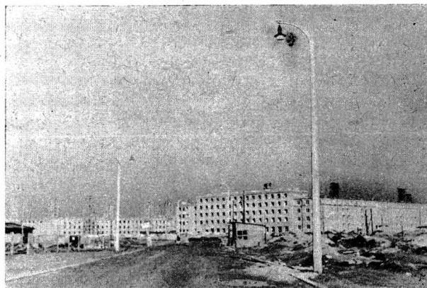
(foto — Miastoprojekt Kraków, W. Łoziński) M.N.H. — Osiedle C1 — fragment (budowa)
