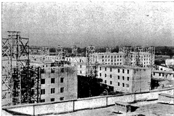
(foto — Miastoprojekt Kraków, W. Łoziński) M.N.H. — Osiedle C 2 — fragment — (budowa)
