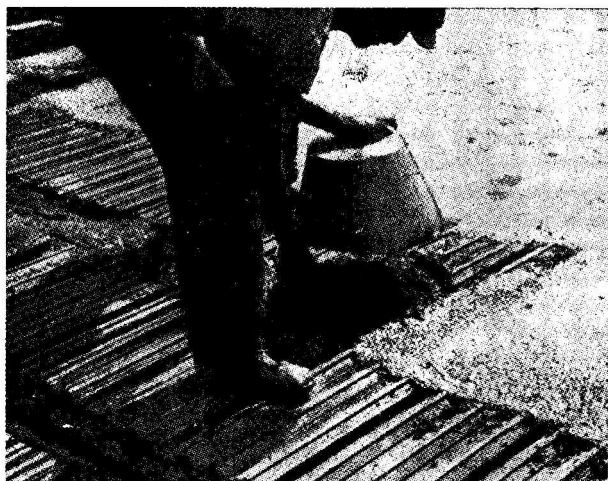
Rys. 16. Betonowanie górnej części stropu
