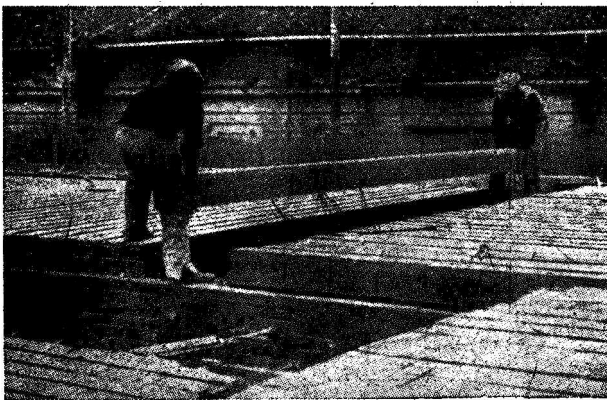
Rys. 10-a — układanie belek
