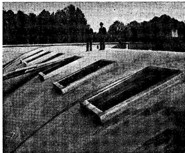
Rys. 29. Świetliki w połaci dachu
