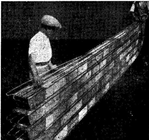
Rys. 8-a — układanie zbrojenia w strefie rozciąganej belki
