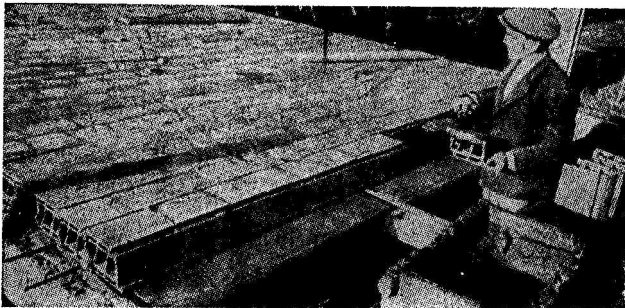
Rys. 32. Wykonywanie stropów z pustaków ząbających się
