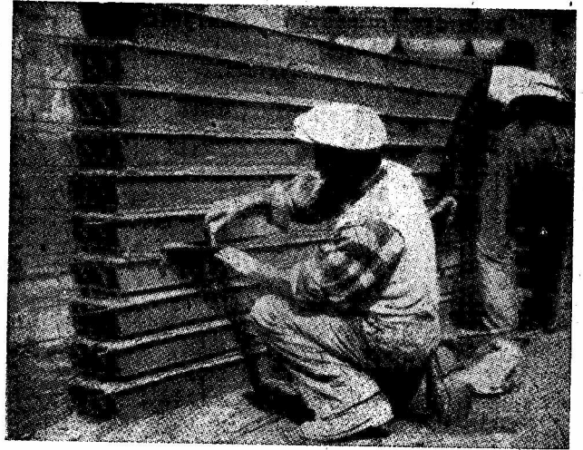
8-b — zalewanie zbrojenia zaprawą
