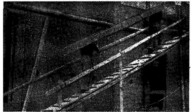
Rys. 11-a. Przenoszenie belek ceramicznych
