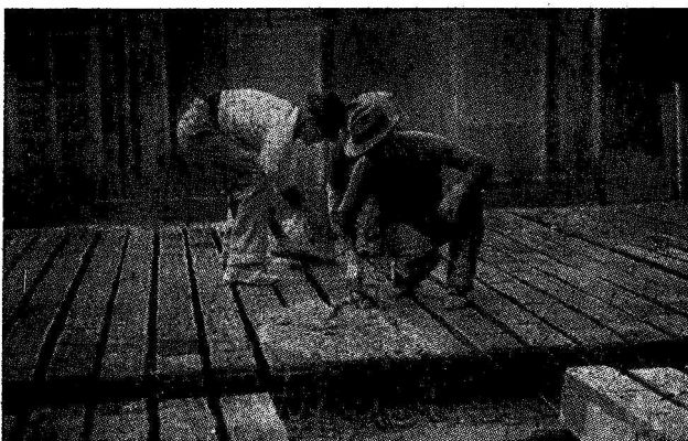
Rys. 10-b — zalewanie fug
