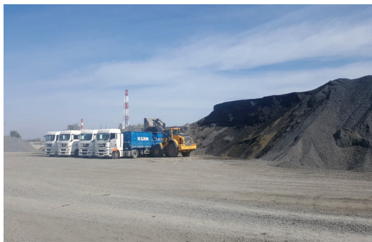
Rys. 4. Załadunek kruszywa Fig. 4. Aggregate loading
