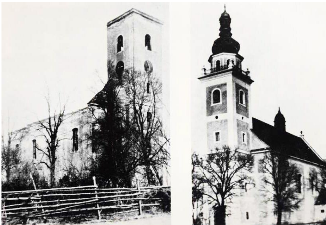
Kościół parafialny pw. św. Michała Archanioła w Smogorzowie Wielkim. Stan przed odbudową. Po odbudowie.
