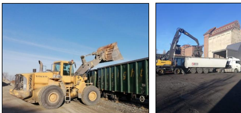
Rys. 2. Punkty przeładunkowe w transporcie kombinowanym: załadunek w zakładzie przeróbczym (z lewej), rozładunek kruszywa na stacji docelowej (z prawej) Fig. 2. Reloading points in combined transport: loading at the processing plant (left), aggregate unloading at the destination station (right)
