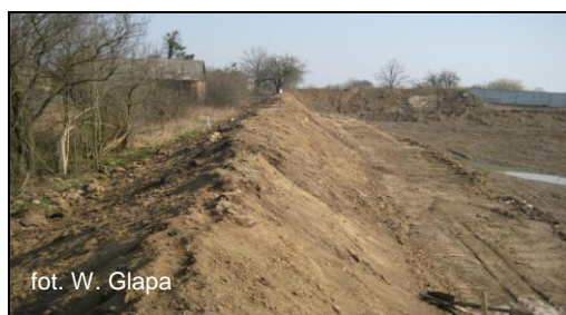
Rys. 2. Obrzeża wyrobisk zabezpieczone wałem ziemnym Fig. 2. An example of protective bushes for the edge of a quarry
