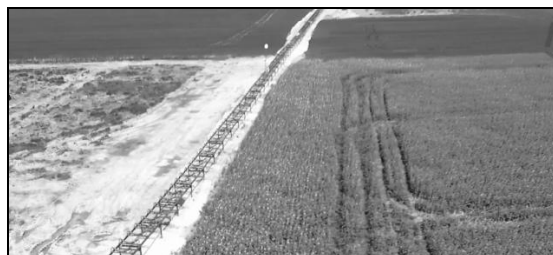
Rys. 7. Przenośnik taśmowy dostarczający urobek do węzłów przerobowych (źródło własne)
