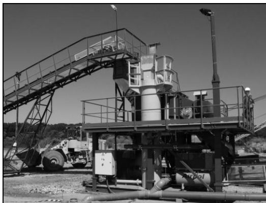
Rys. 1 Klasyfikator pulsacyjny K-100 na konstrukcji mobilnej Fig. 1. K-100 pulsating classifier on a mobile base
