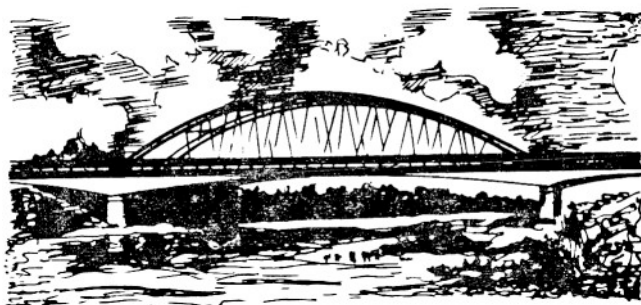
Most przez Sotę w Kobiernicach, L = 26 + 68 + 26 Zbudowany w 1960 r wg projektu J. Grycza [84]
