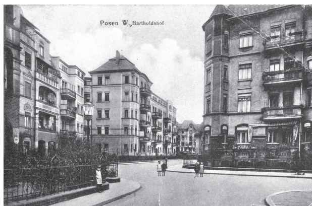
Fig. 5. Poznań, Deutsche-Beamten-Wohnungs-Bau-Verein in Skryna Street, 1905.
