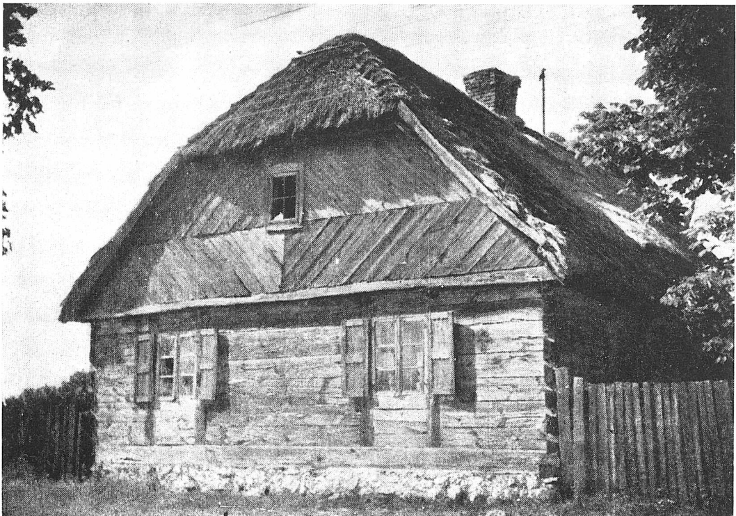
Ryc. 7. Ozdobnie szalowany dach naczółkowy. Dzierżania, pow. Płoński.
