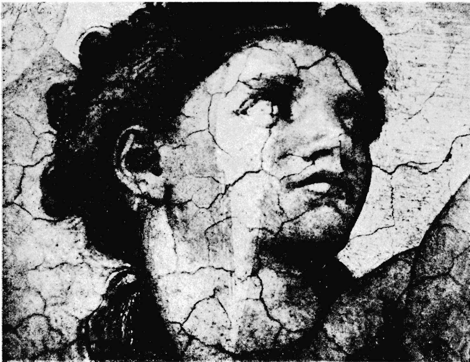
Rys. 6. Rysy na tynku wapiennym pod malowidłem M. A. Buonarroti.
