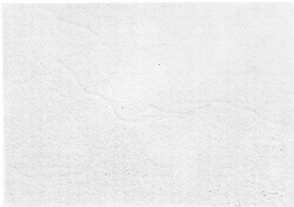
Rys. 8. Skażdowania na zbyt tłustym tynku wapiennym.
