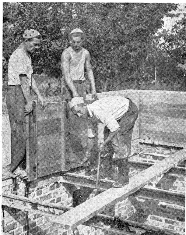
Zakładanie formy drewnianej na drugi bliźniak
