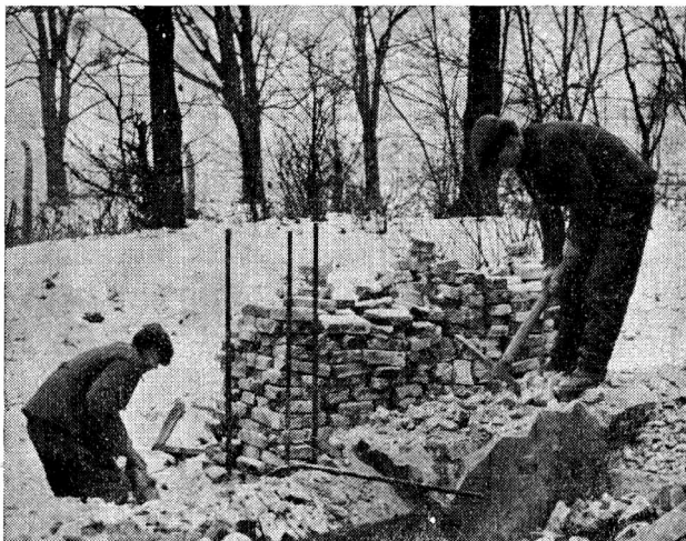
Zespół PGR Wrocław — Osobowice. Jan Krawczyk i Bronisław Lech przygotowują materiał z rozbiórki na nową budowę
