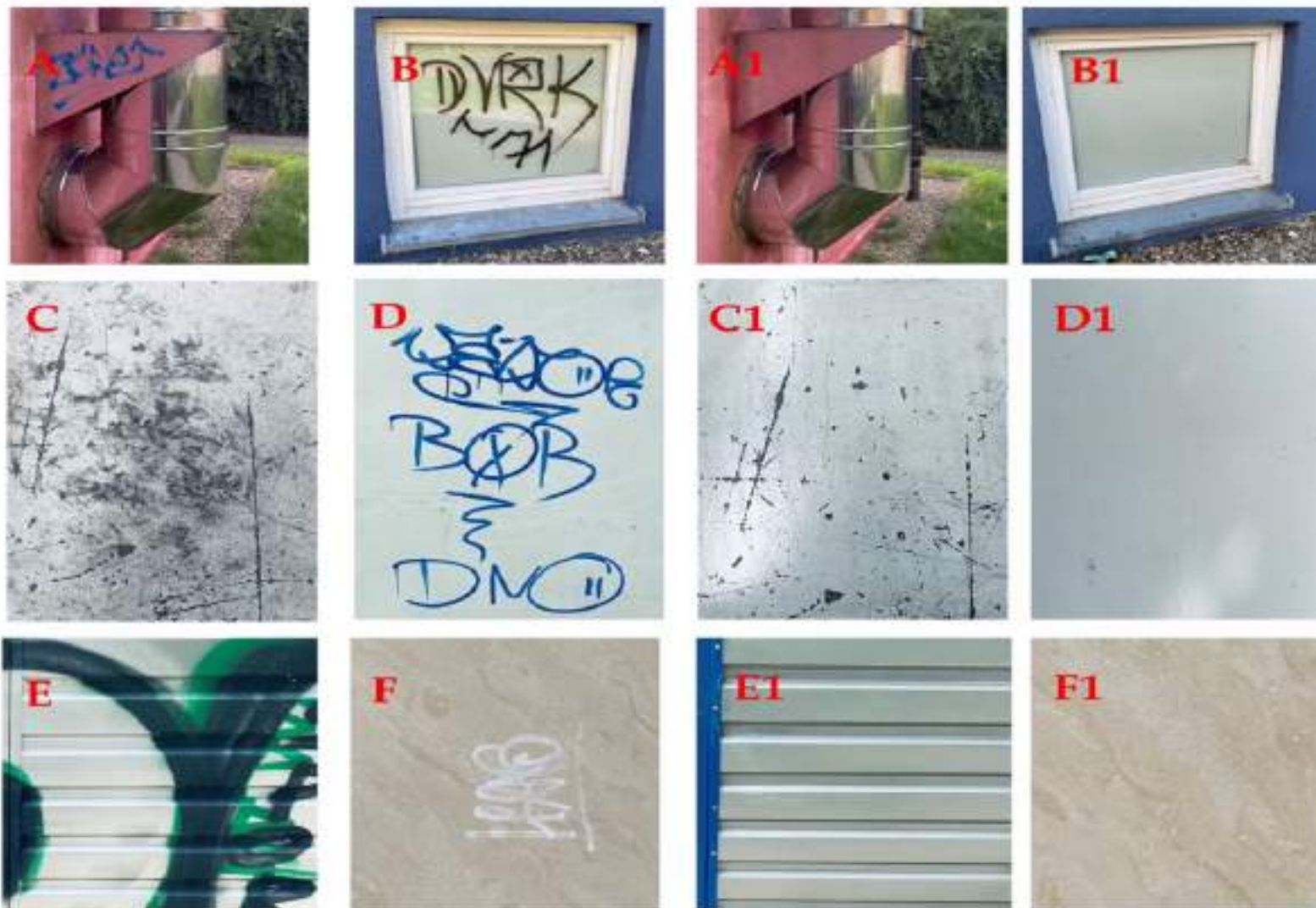
Rysunek 20. Różne powierzchnie oczyszczane za pomocą zielonego nanostrukturalnego płynu GNF nr. 1 we Wrocławiu: (A) stal nierdzewna; (B) szkło okienne; (C) podłoga betonowa; (D) podłoga betonowa z powłoką ochronną; (E) fasada aluminiowa; (F) płytki ceramiczne [A5].
