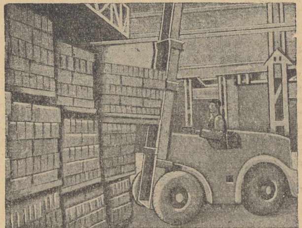
Rys. 1. Dostawa cegły sklepieniowej w sąsiedztwie remontowanego pieca
