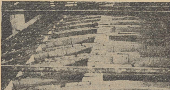
Rys. 1. Sklepienie skrzynkowe. Widok z góry
