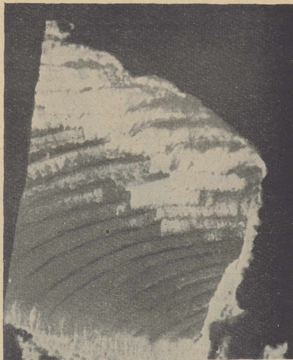
Rys. 1. Sklepienie martenowskie przedwcześnie zużyte wskutek zastosowania wyrobów krzemionkowych o różnej ogniotrwałości pod obciążeniem. Na wewnętrznej stronie sklepienia widać ciemne pasy nadmierne wytapiających się kształtek żeberkowych o małej ogniotrwałości pod obciążeniem
