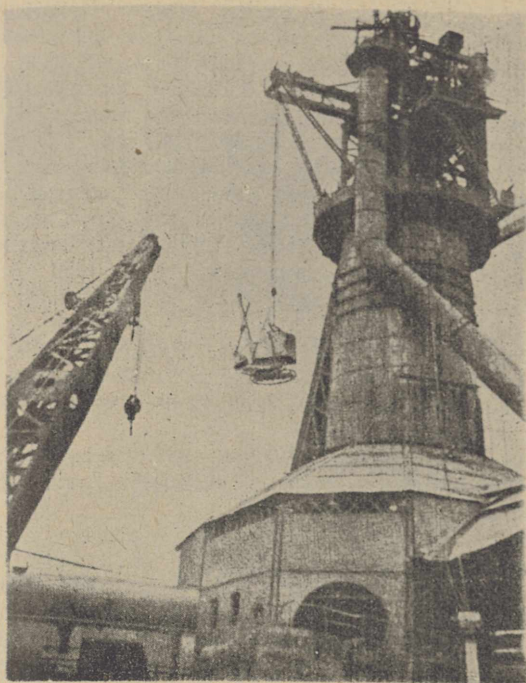
Rys. 4. Opróżnianie wielkiego pieca przy pomocy ekskawatorki [20]
