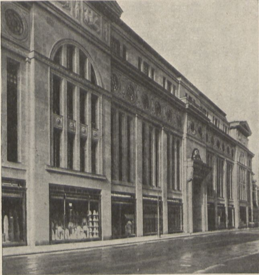
Warenhaus Leonhard Tietz in Köln.
