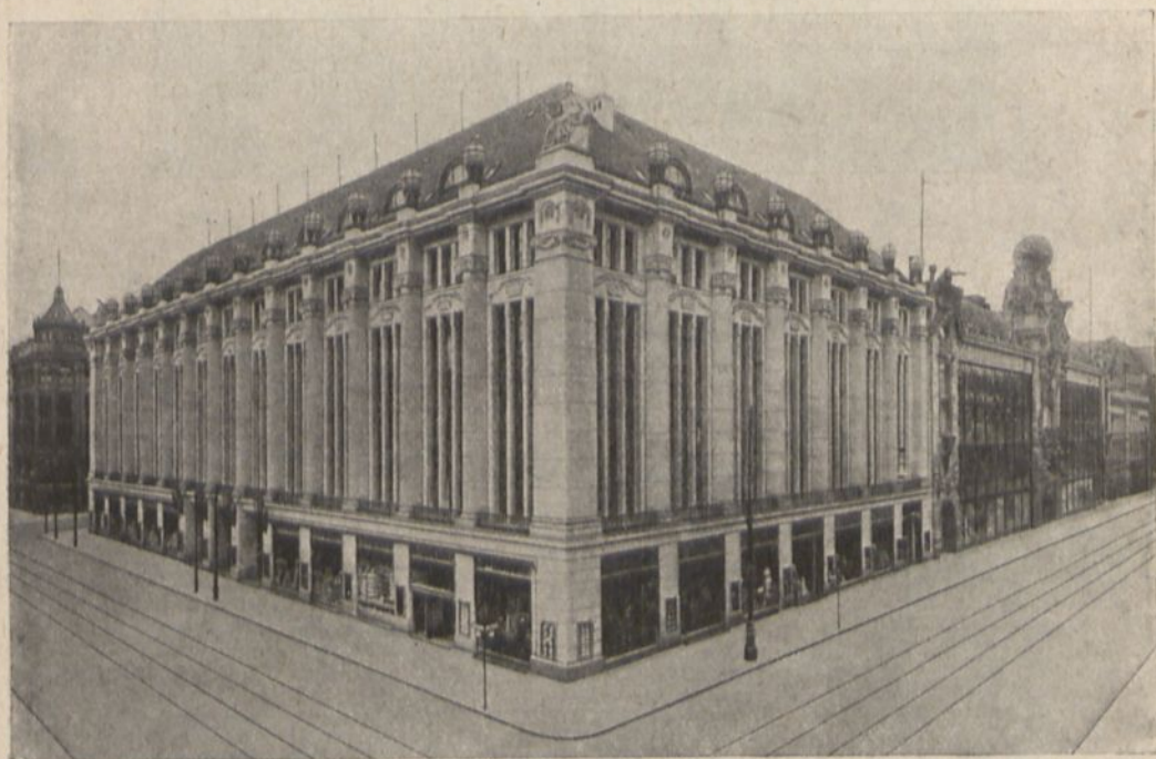
Gesamtansicht des Warenhauses Hermann Tietz in Berlin.
