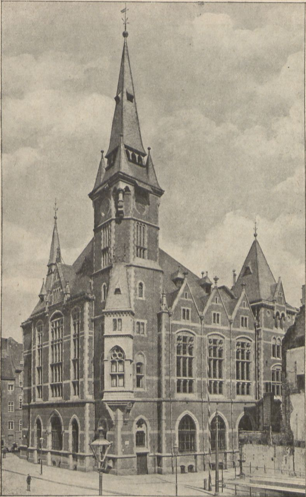
Sparkasse in Breslau 148) . Arch.: Baurat Plüddemann.
