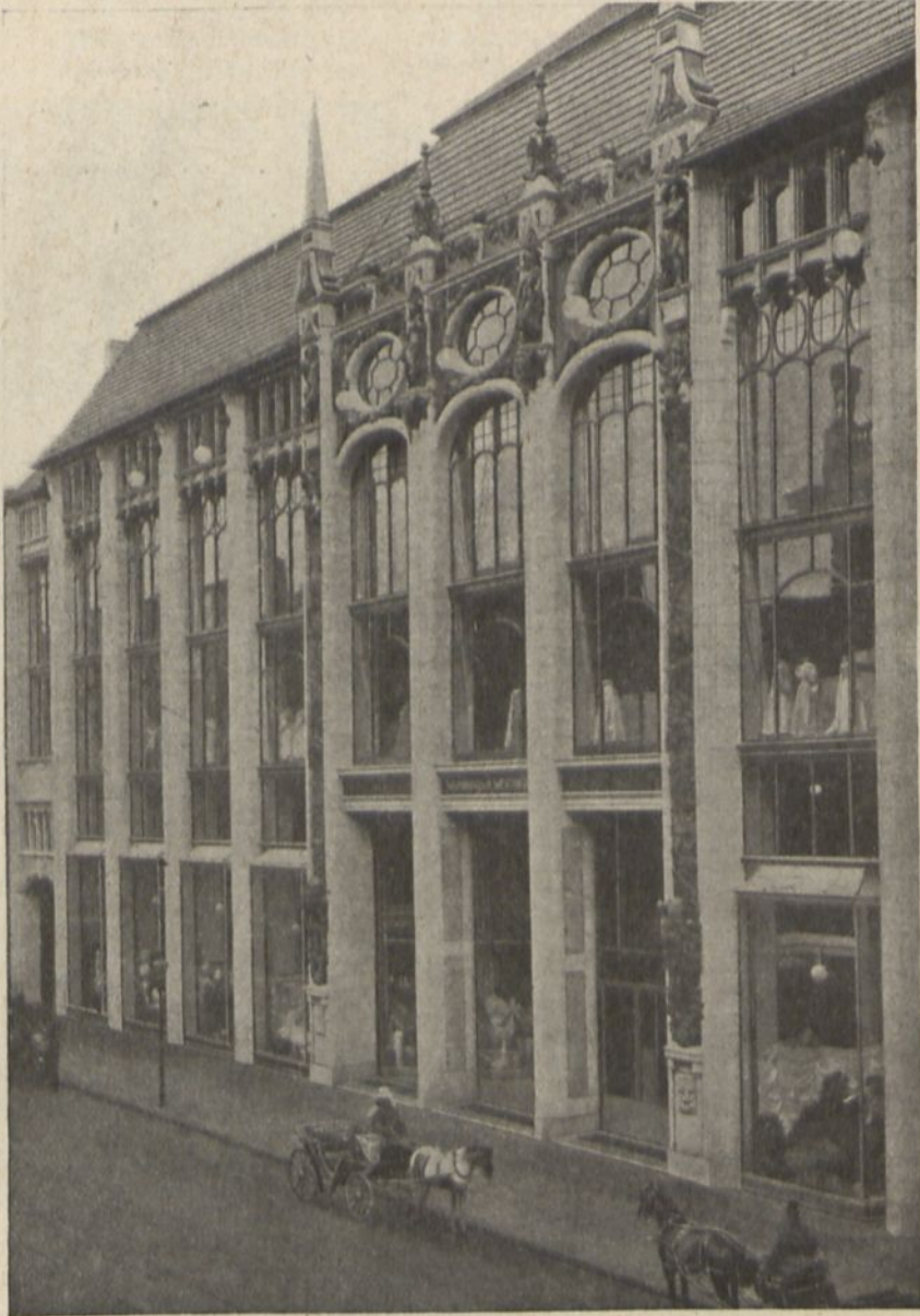
Warenhaus Wertheim in Berlin. (I. Bauperiode.)
