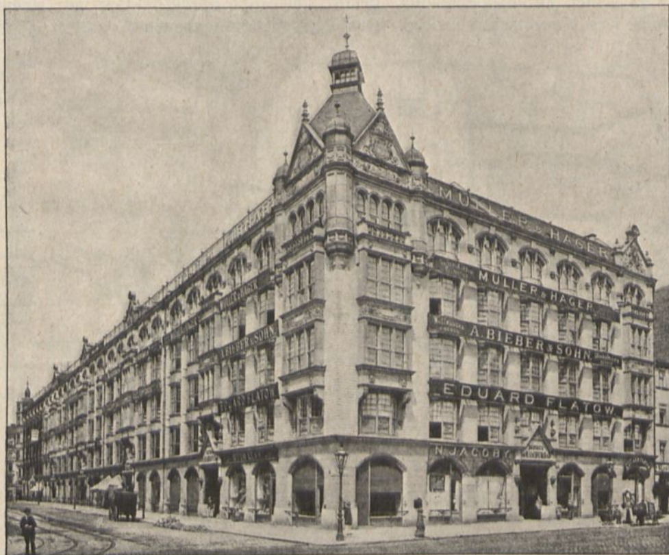
Geschäftshaus Kaiser-Wilhelm-Straße, Rosenstraße und Neue Friedrichstraße in Berlin 54 ).
