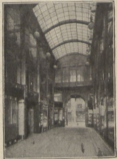
Paffage Stollwerk-Haus in Köln a. Rh. 56) .
