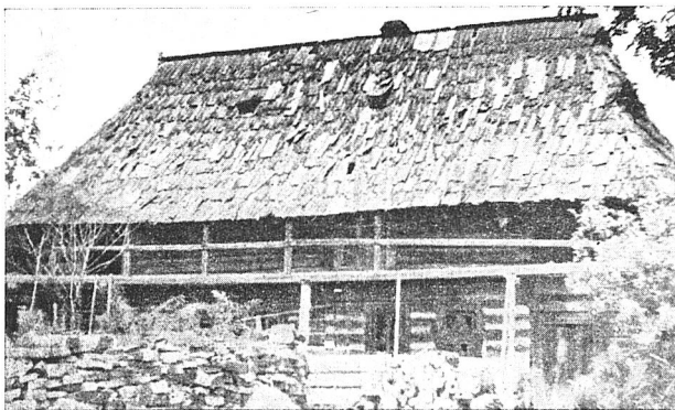
Ryc. 14. Chałupa z wyżką podparta słupami, Katarzyny Zondlak w Podsarniu. Fot. R. Reinfuss 1949 r.
