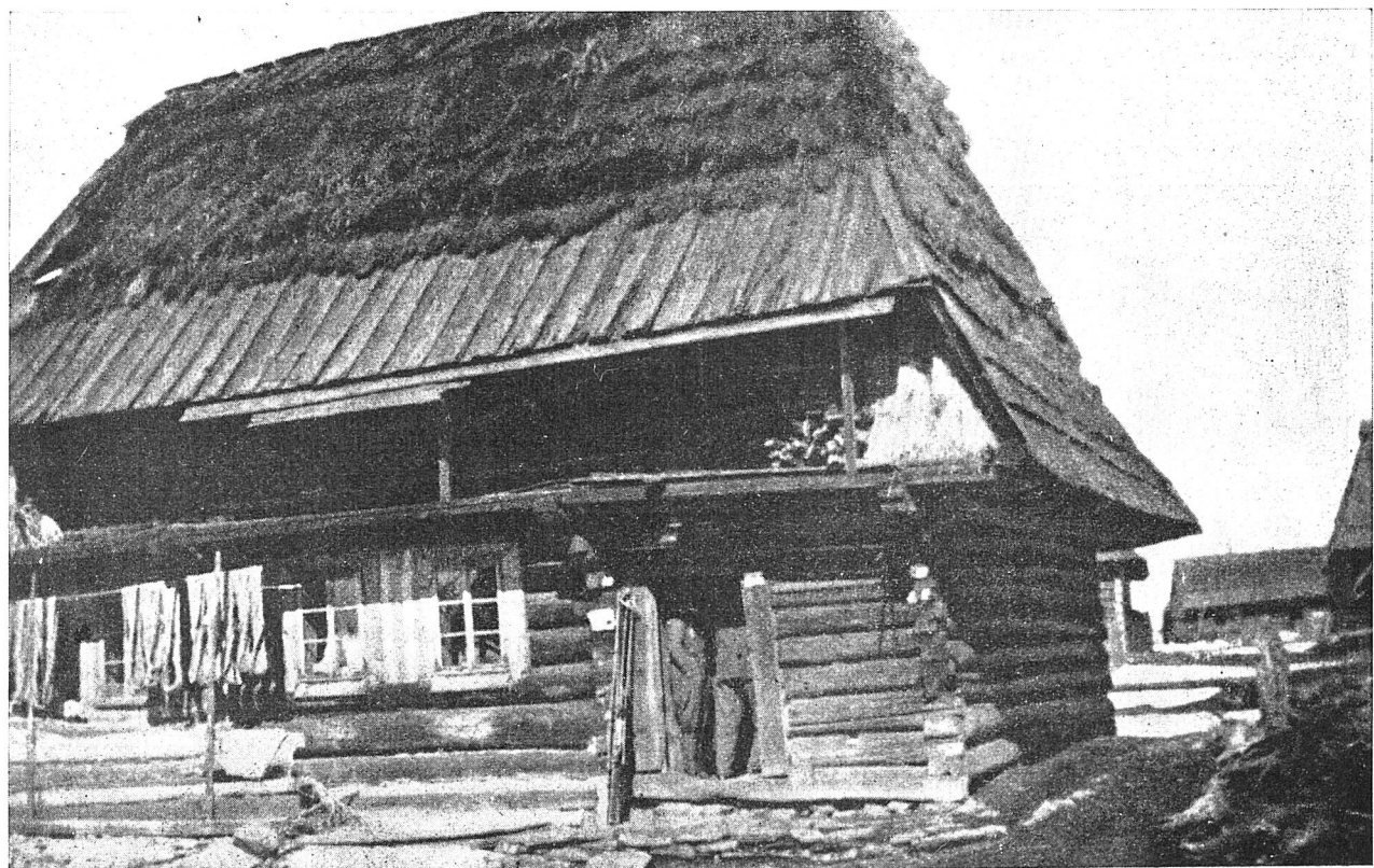
Ryc. 17. Chałupa z Piekelnika, przeniesiona z Lipnicy, data na sosrębie 1934. Fot. dr M. Gotkiewicz.
