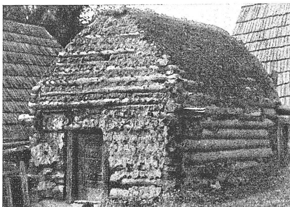
Ryc. 29. Sypańiec po zdjęciu dachu. Kocwin, pow. Nowy Targ. Fot. R. Reinfuss 1938 r.
