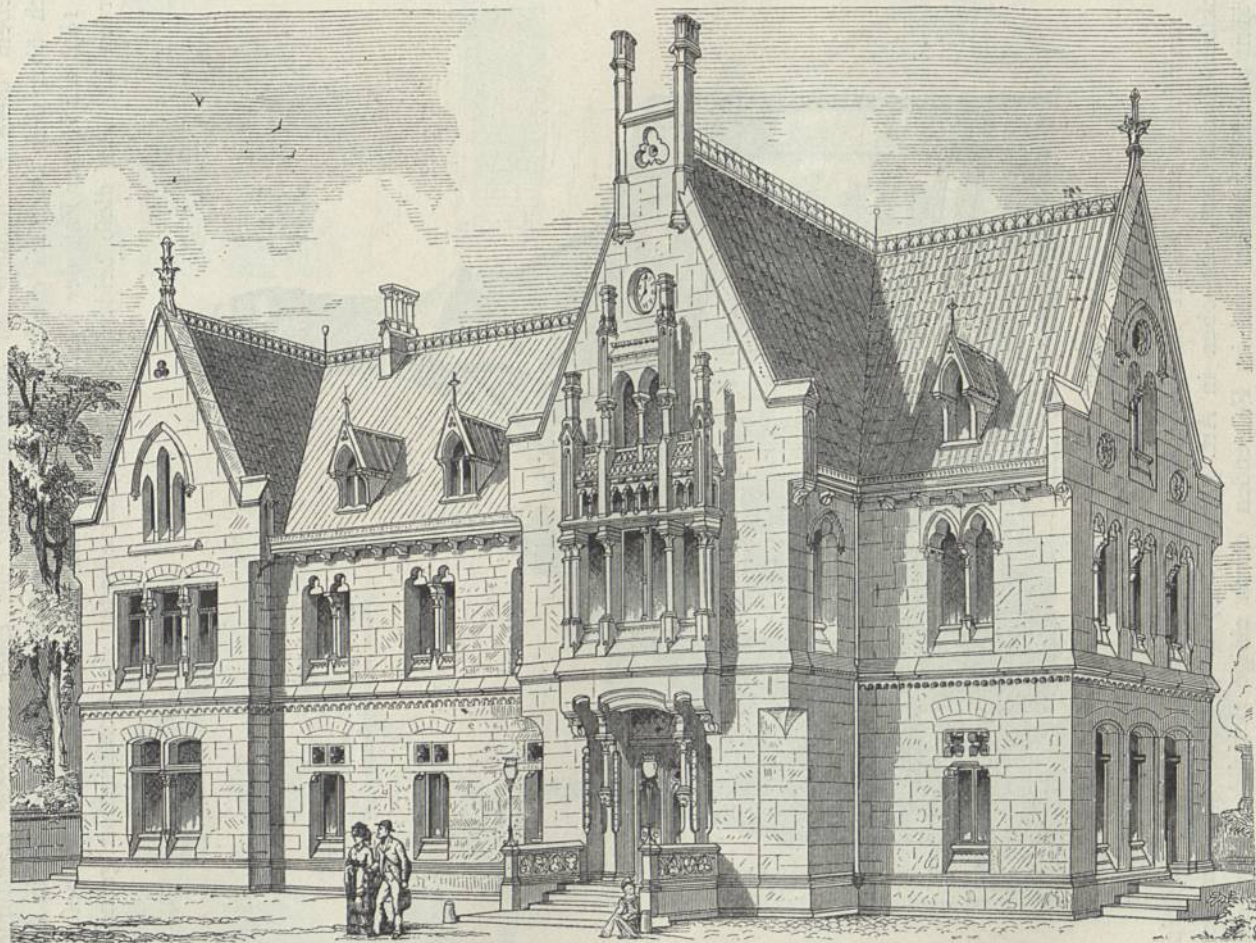
Stationsgebäude zu Lengerich 134 ).
