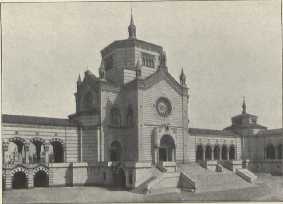
Mittlerer Teil der Hallenbauten auf dem Campo Santo zu Mailand. Anficht von der StraÙe aus.
