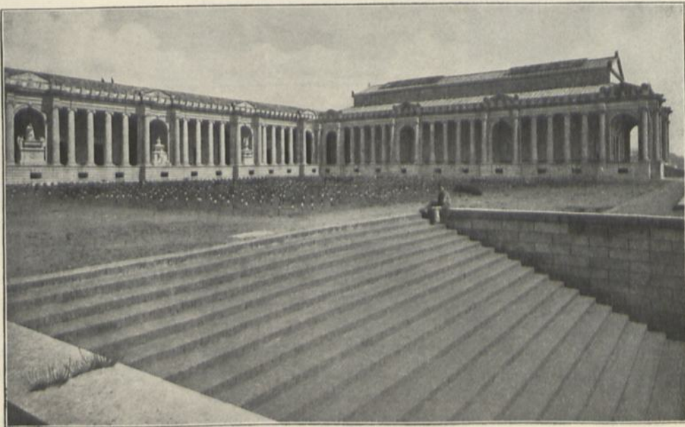
Hallengruftanlage auf dem Friedhof zu Meffina 94 ).
