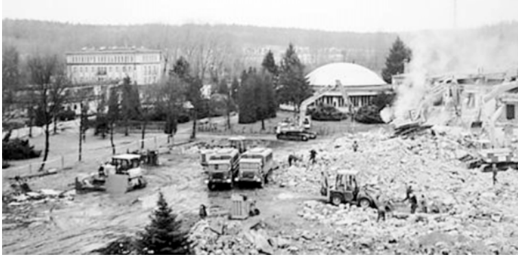
Ryc. 6. Fotografia z budowy kopalni „Konrad” (zdjęcie archiwalne)
