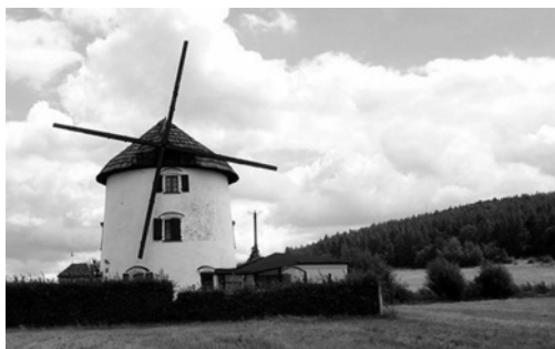
Ryc. 14. Wiatrak holender murowany w Gogołowie (pow. świdnicki)
