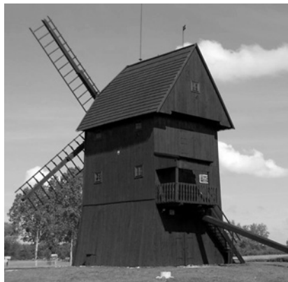
Ryc. 10. Wiatrak w Bukówcu Górnym z XIX w., częściowo odbudowany
