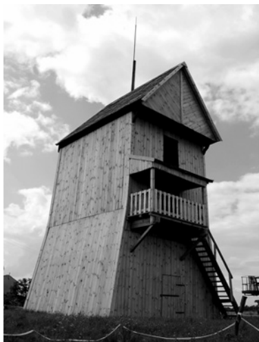
Ryc. 8. Wiatrak w Tworzanicach, konstrukcja z 1812 r.
