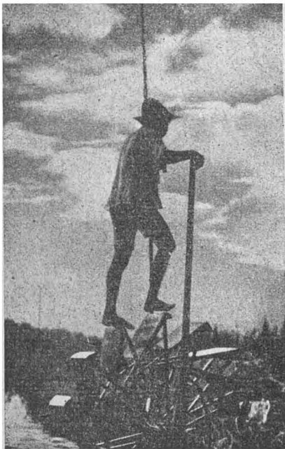
Rys. 1. Podnoszenie wody przy pomocy koła czerpakowego nadeptywanego przez człowieka.
