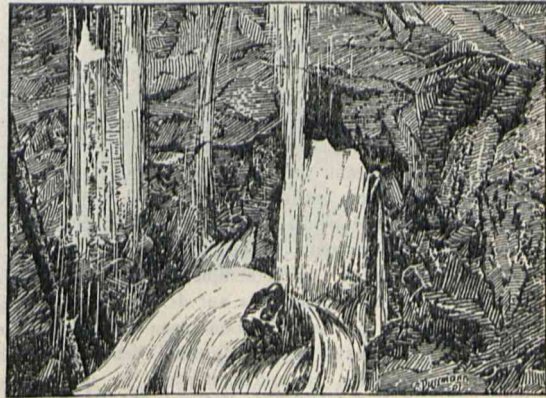
Wassereinbruch im Stollen II bei Station 4462.
