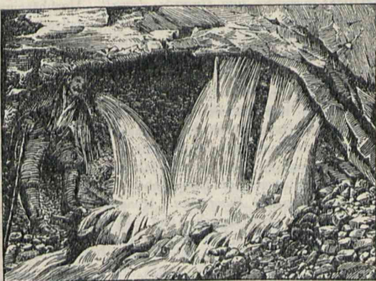
Wassereinbruch im Stollen II bei Station 4442.
