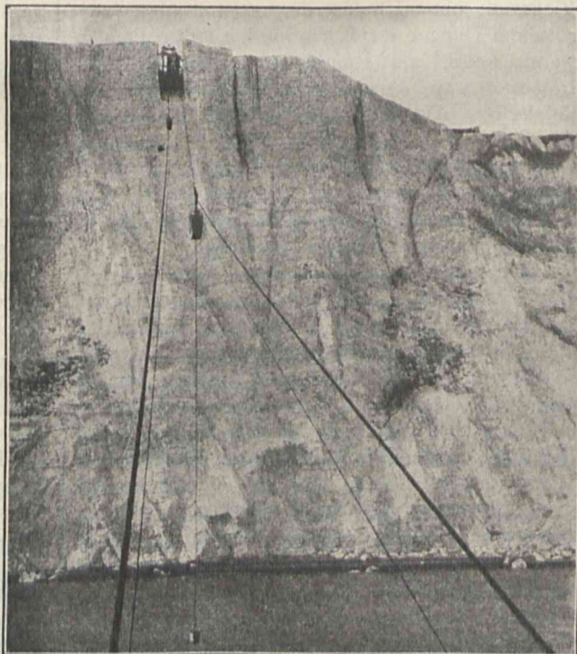
Die Klippen von Beachy Head und die Drahtseilbahn zur Beförderung der Baumaterialien nach dem Baugerüst.
