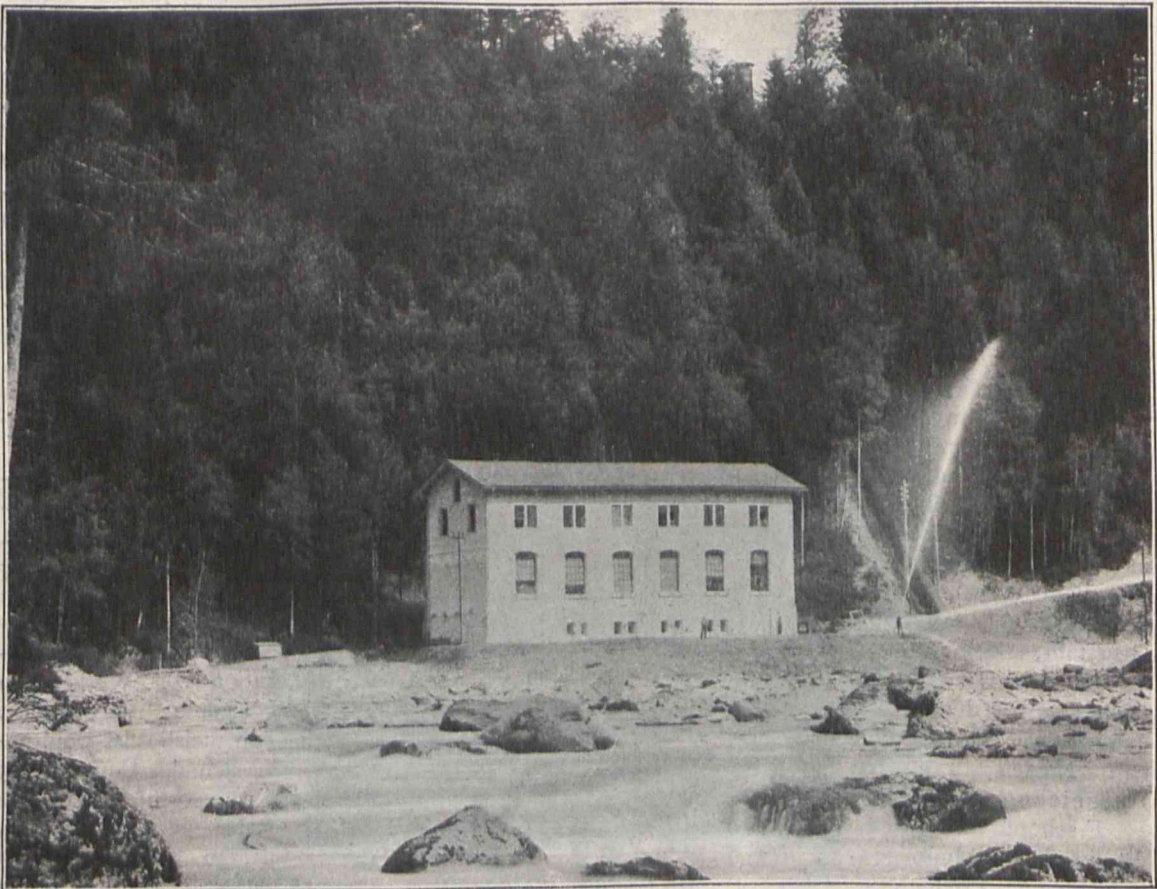
Maschinenhaus zum Electricitätswerk an der Sihl. Der Luftschaft auf der Höhe ist oben sichtbar.
