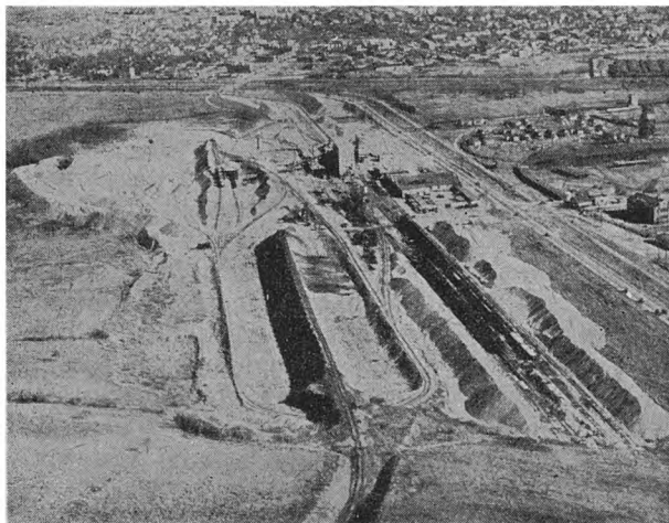
Rys. 3. Ogólny widok dołów żużlowych i urządzeń do produkcji żużła kawałkowego (według Josephsona, Sillersa i Runnera [4])
