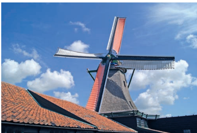
22. Widok wiatraka z zewnątrz. Fot. R. Eysymontt
