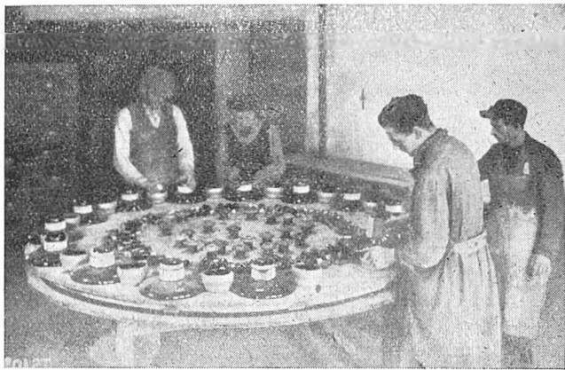
Rys. 6. Montaż izolatorów wiszących
